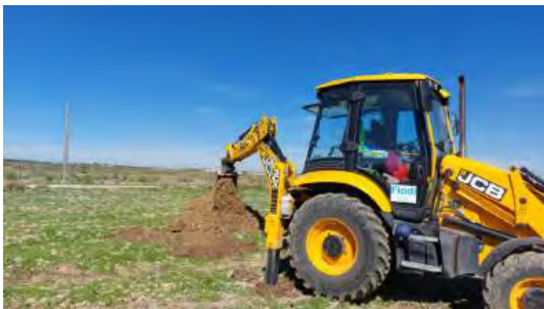
Figura Nº 16.- Fotografía de la ejecución de la calicata referida como C-04.
