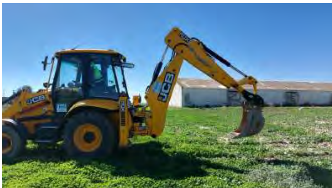
Figura Nº 22.- Fotografía de la ejecución de la calicata referida como C-10.
