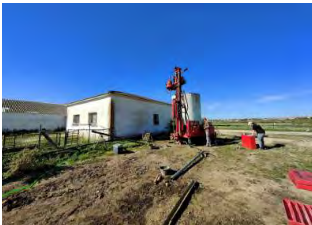
Figura Nº 9.- Imagen de la ejecución del sondeo mecánico y rotativo con extracción continua de testigo referido como S-02.
