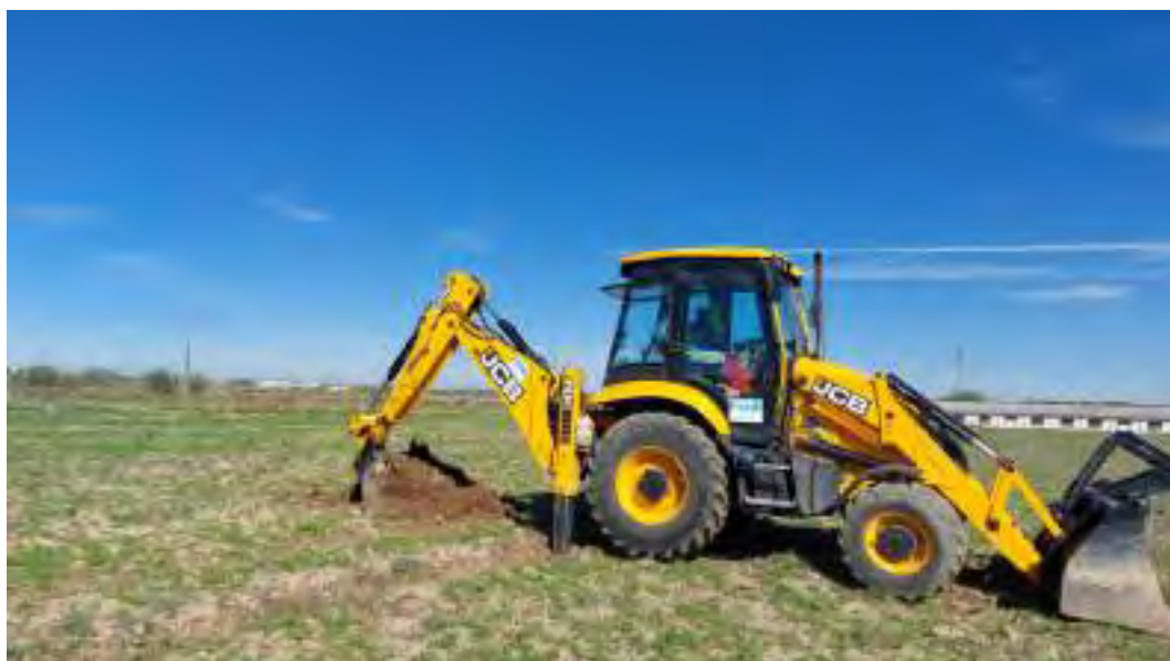
Figura Nº 13.- Fotografía de la ejecución de la calicata referida como C-01.
