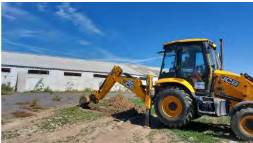
Figura Nº 18.- Fotografía de la ejecución de la calicata referida como C-06.
