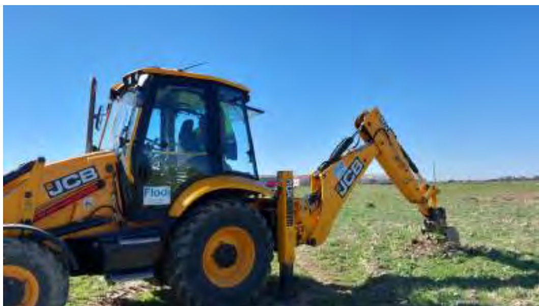
Figura Nº 14.- Fotografía de la ejecución de la calicata referida como C-02.
