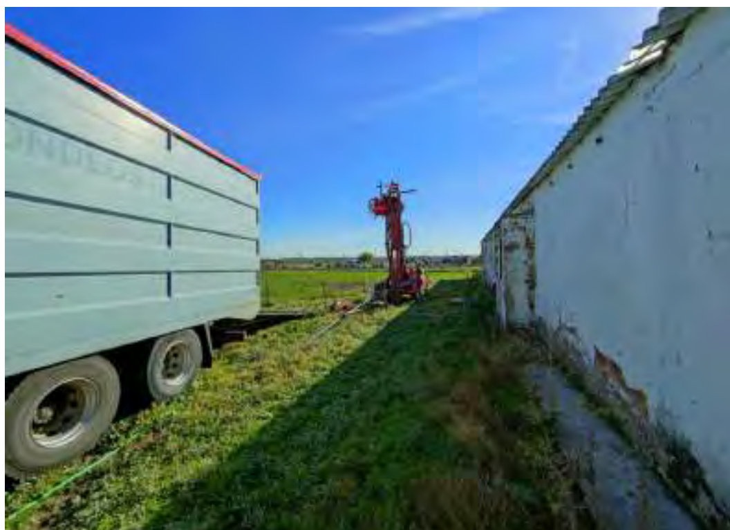
Figura Nº 10.- Imagen de la ejecución del sondeo mecánico y rotativo con extracción continua de testigo referido como S-03.
