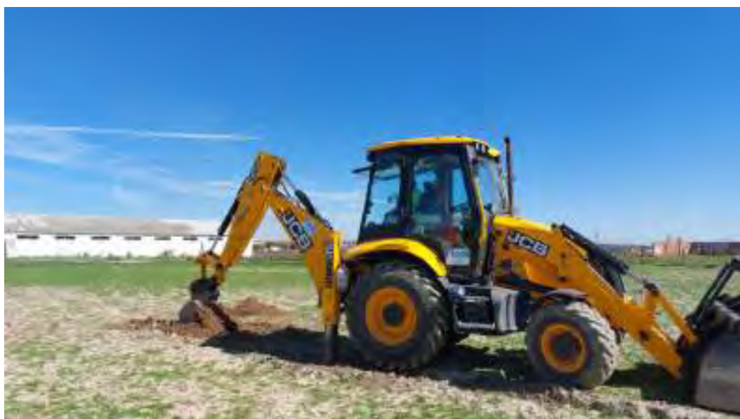
Figura Nº 20.- Fotografía de la ejecución de la calicata referida como C-08.
