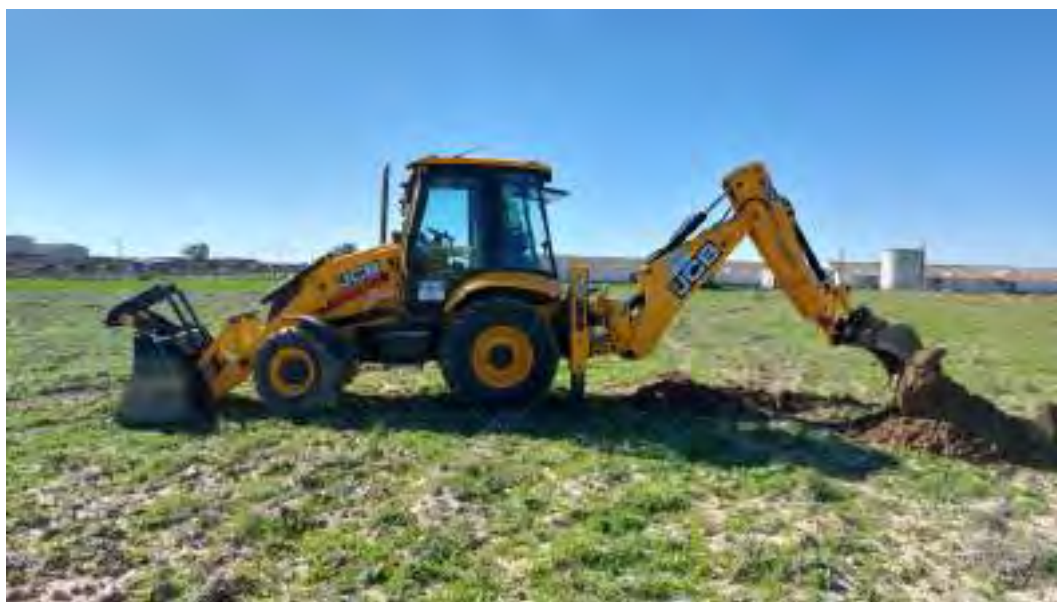
Figura Nº 15.- Fotografía de la ejecución de la calicata referida como C-03.
