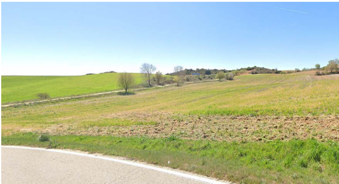
Entorno del apoyo nº 420 del tramo LEAT 220kV ST Taracena-ST Alcalá II Colectora (Ap 412 PAS - Ap 425 PAS). Vista orientada a suroeste
