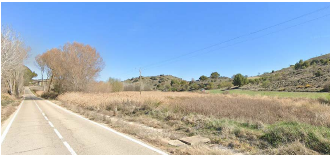
Entorno del apoyo nº 418 del tramo LEAT 220Kv ST Taracena-ST Alcalá II Colectora (Ap 412 PAS - Ap 425 PAS). Vista orientada a noreste
