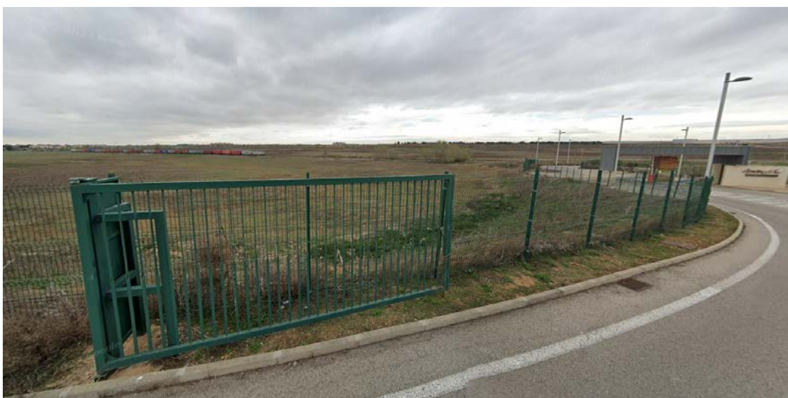
Entorno del tramo de línea soterrado LEAT 220kV ST Yunquera-ST Cisneros REE. Vista orientada a norte
