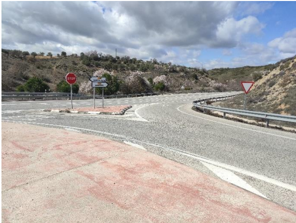
Ilustración 26. Enlace carreteras M-219 con M-220
