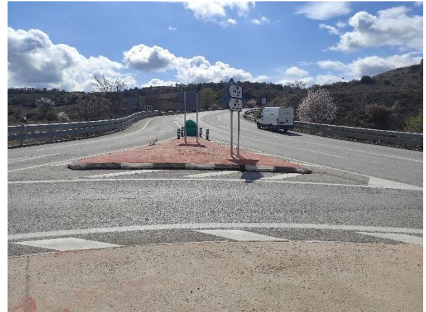
Ilustración 27. Enlace carreteras M-219 con M-220
