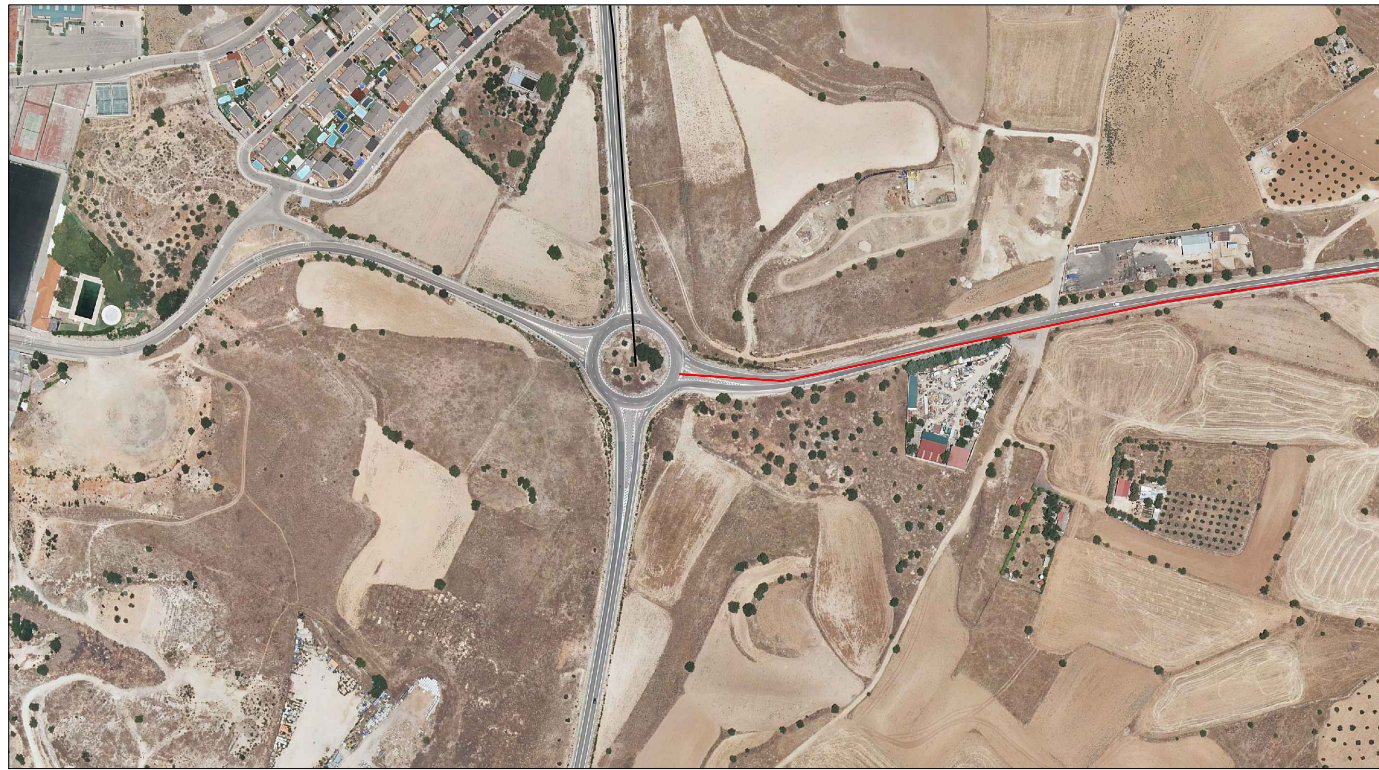
-01- ENLACE CARRETERA M-209 EN CAMPO REAL
