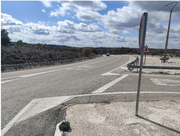
Ilustración 28. Enlace carreteras M-219 con M-220
