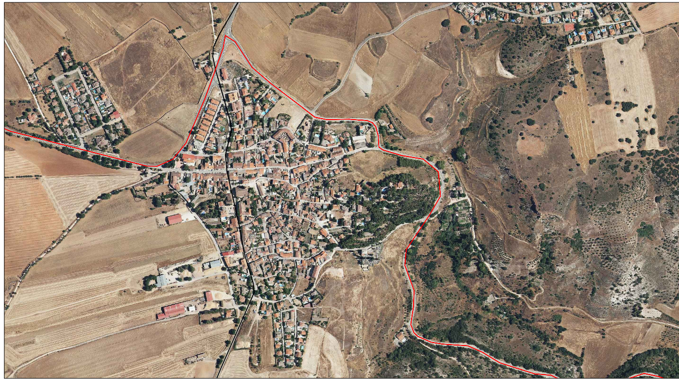
-NE4- CARRETERA M-225 - TRAVESIA PEZUELA DE LAS TORRES
