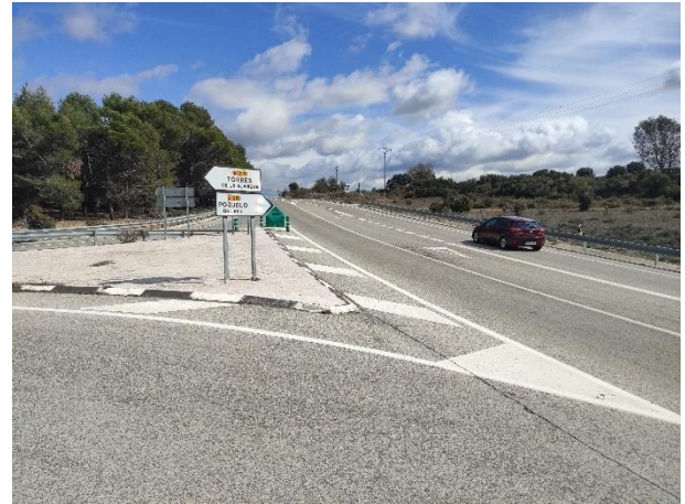
Ilustración 29. Enlace carreteras M-219 con M-220
