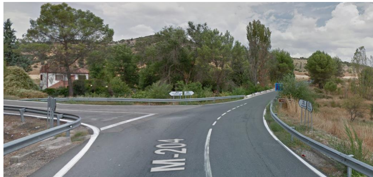
Ilustración 36. Desvío entre carreteras M-204 y M-215 (Giro izquierda)
