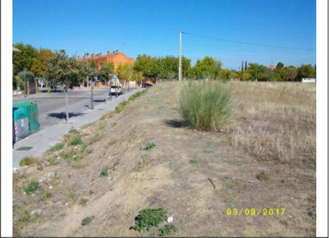
Fotografía nº 10: talud de terreno en límite del ámbito con la calle San Babilés
