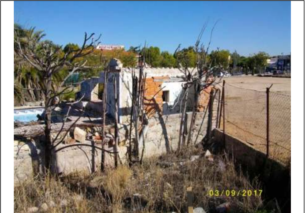
Fotografía nº 94 (Parcela B): edificación parcialmente demolida (restos de escombros cerámicos)
