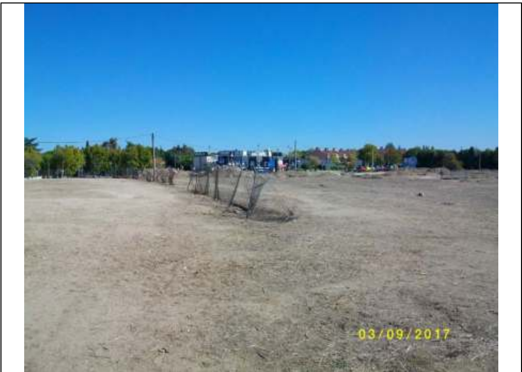
Fotografía nº 00: zona de explanación de terreno (con acopio de tierras)
