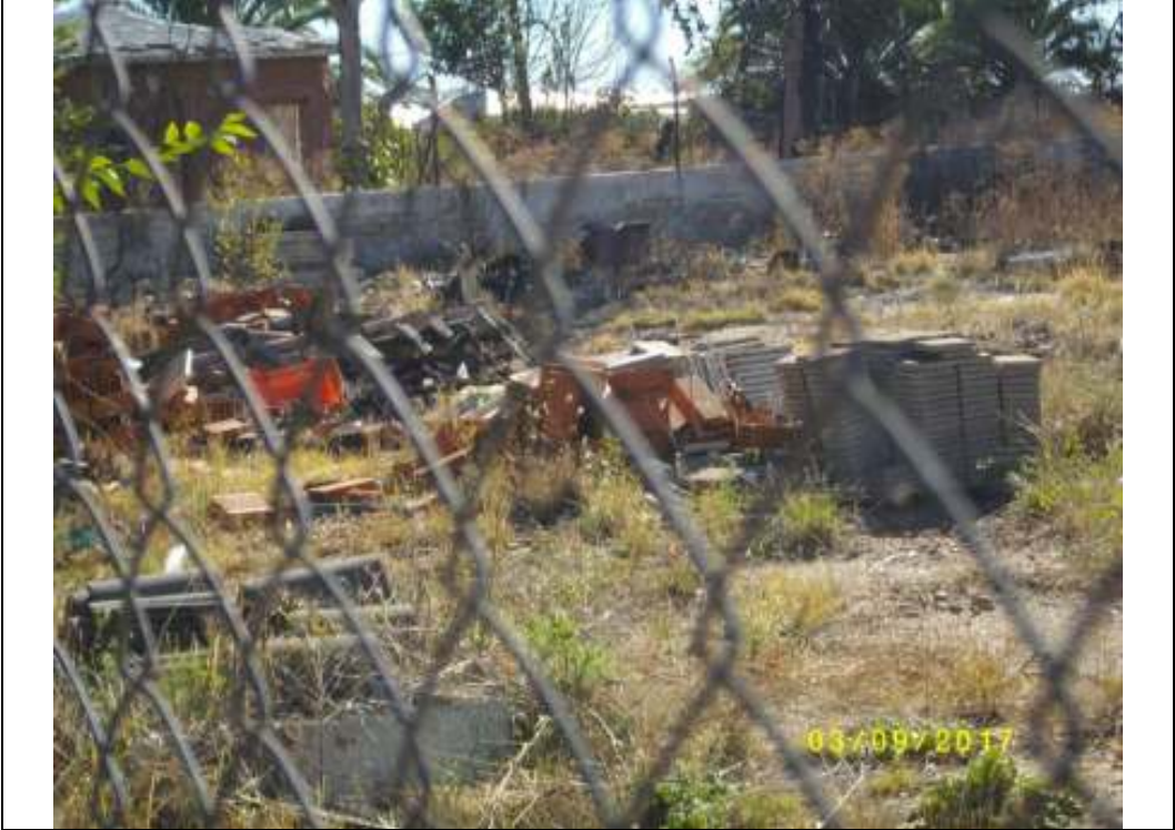
Fotografía nº 71 (Parcela A): acopio de materiales de construcción (hormigón y cerámicos)
