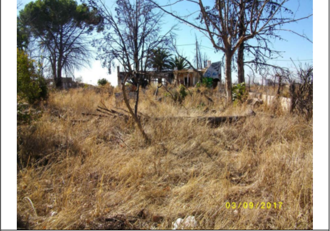
Fotografía nº 11 (Parcela B): edificación en ruinas y parcela con vegetación
