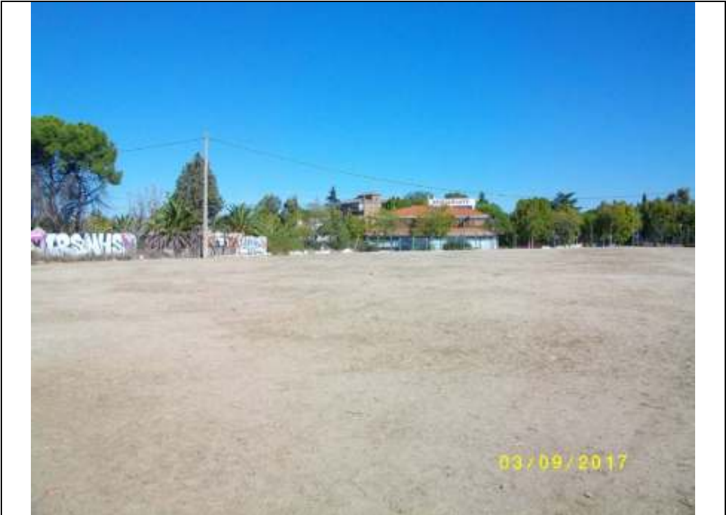
Fotografía nº 99: imagen de zona de explanación (sin acopios de materiales)
