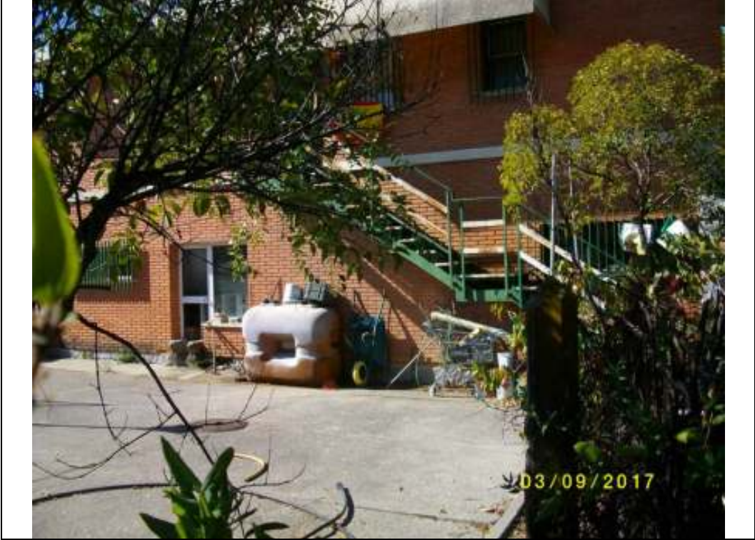
Fotografía nº 23 (Parcela D): depósito de gasoil aéreo sobre solera
