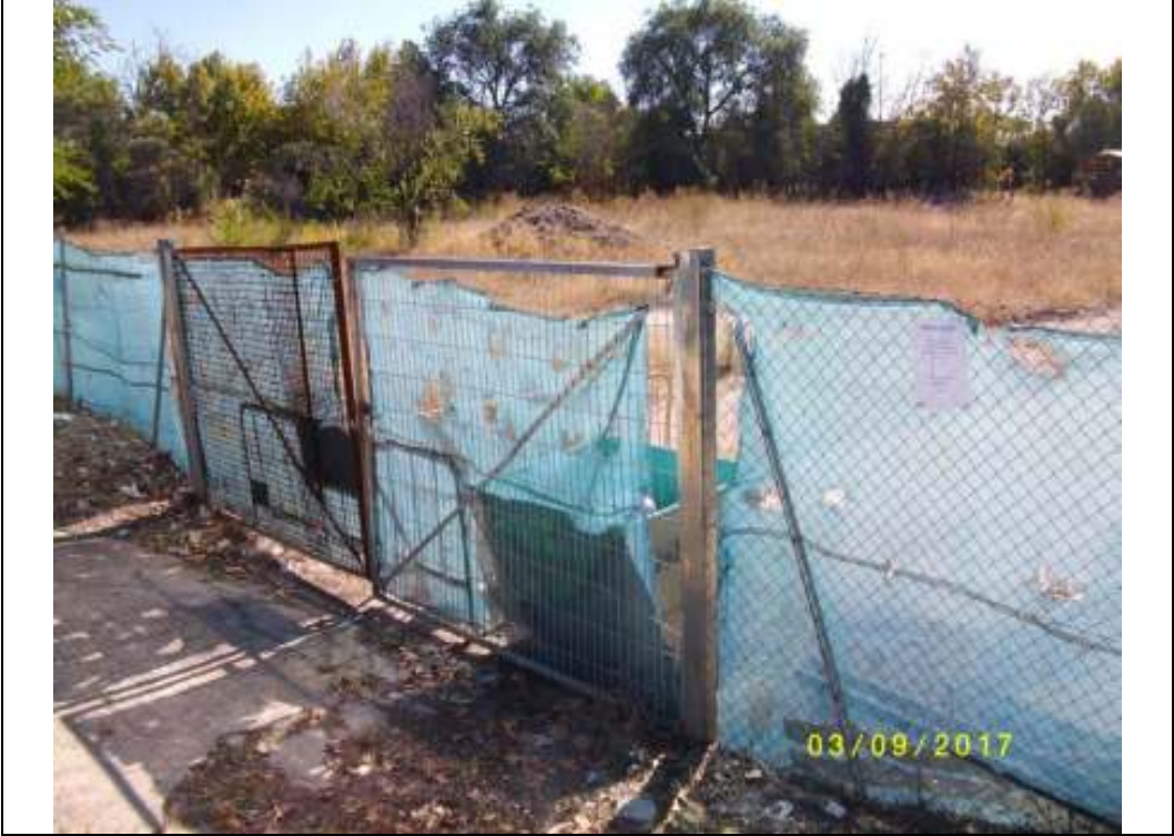
Fotografía nº 15 (Parcela C): acopio de tierras de excavación
