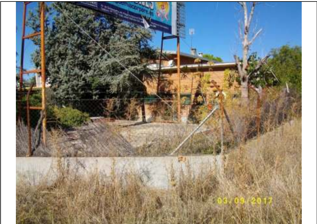
Fotografía nº 28 (Parcela D): edificación auxiliar en esquina de parcela
