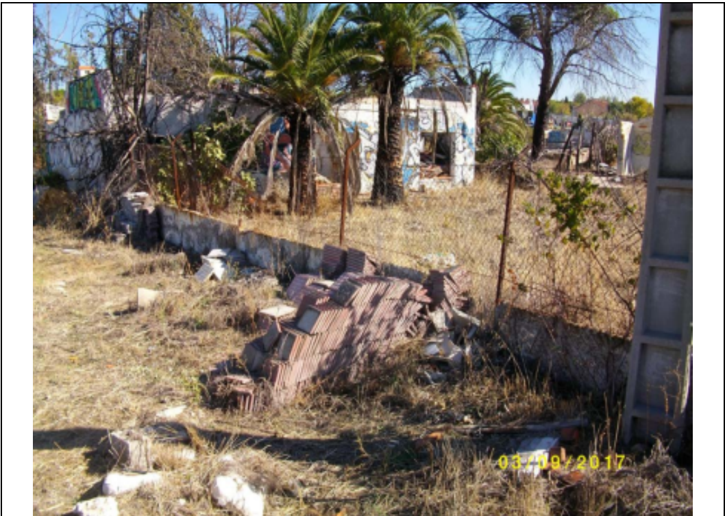
Fotografía nº 84 (Parcela A): acopio de baldosas hidráulicas de cemento
