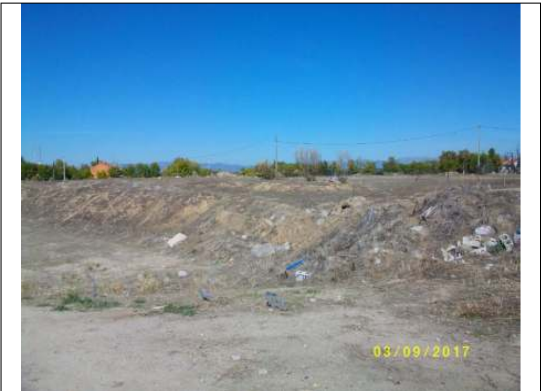
Fotografía nº 06: talud de tierras con residuos inertes de construcción (hormigón y cerámicos)
