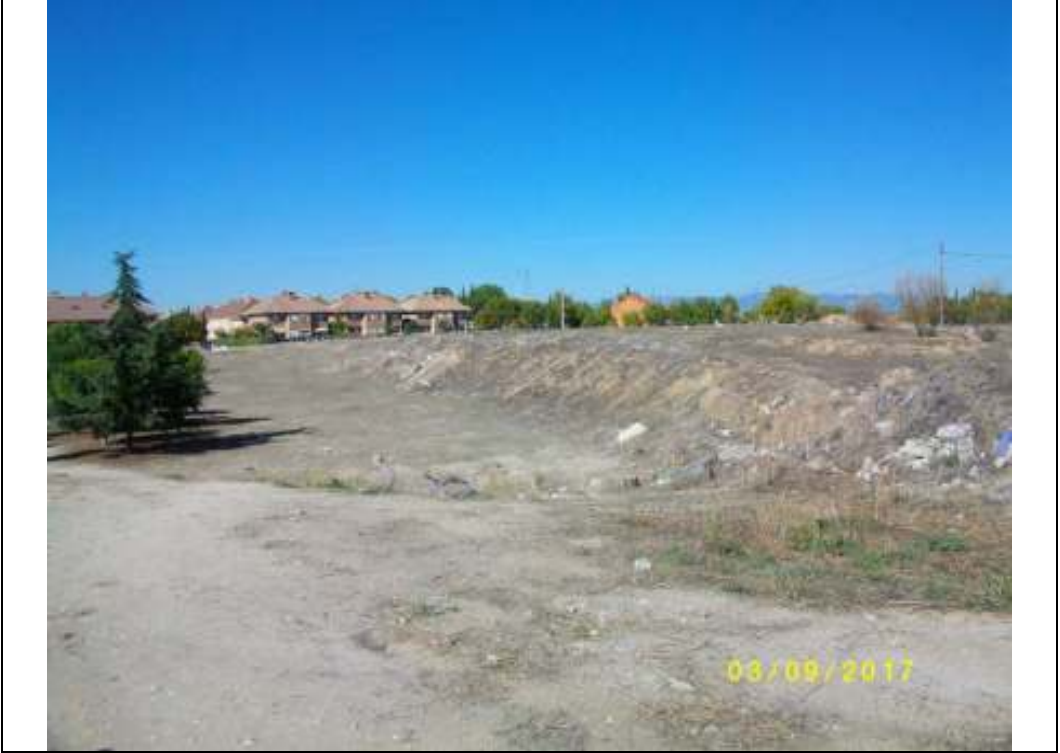
Fotografía nº 05: talud de tierras de explanación (con residuos de hormigón y cerámicos)
