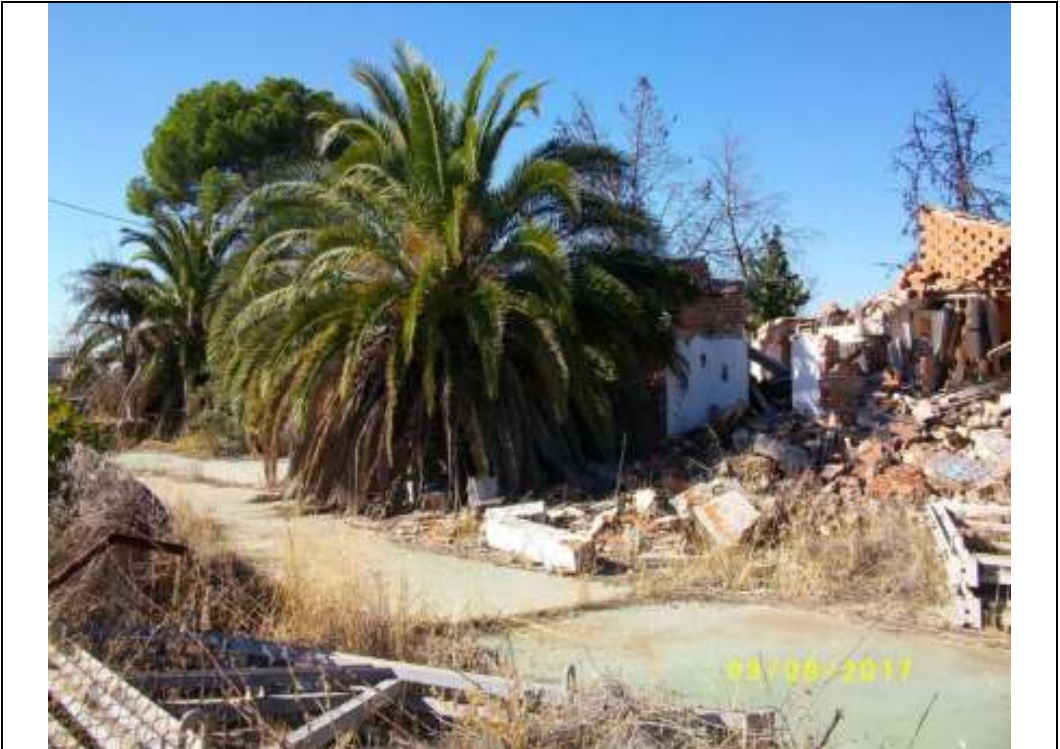
Fotografía nº 98 (Parcela B): edificación demolida (restos cerámicos, hormigón y metálicos)
