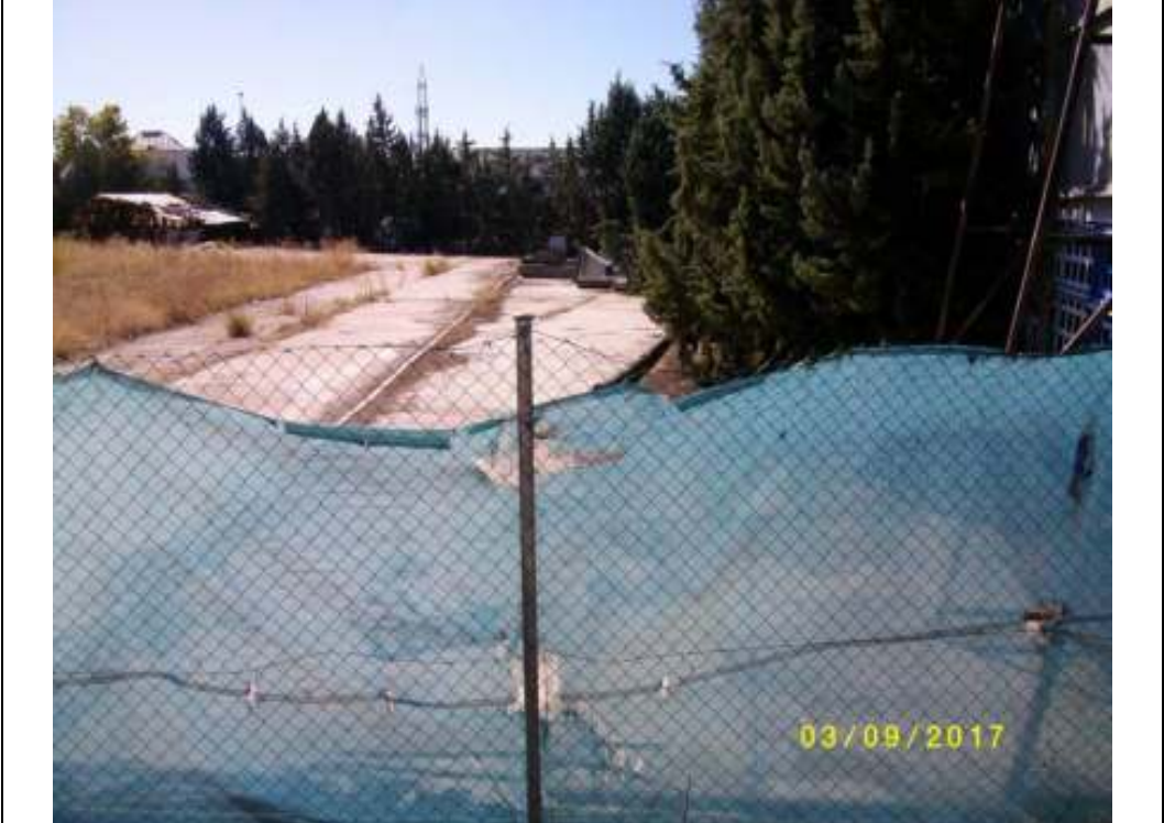
Fotografía nº 13 (Parcela C): zona con solera de hormigón
