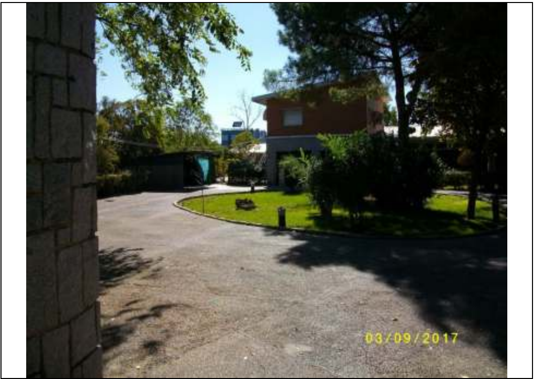
Fotografía nº 21 (Parcela D): solera de acceso y edificación principal
