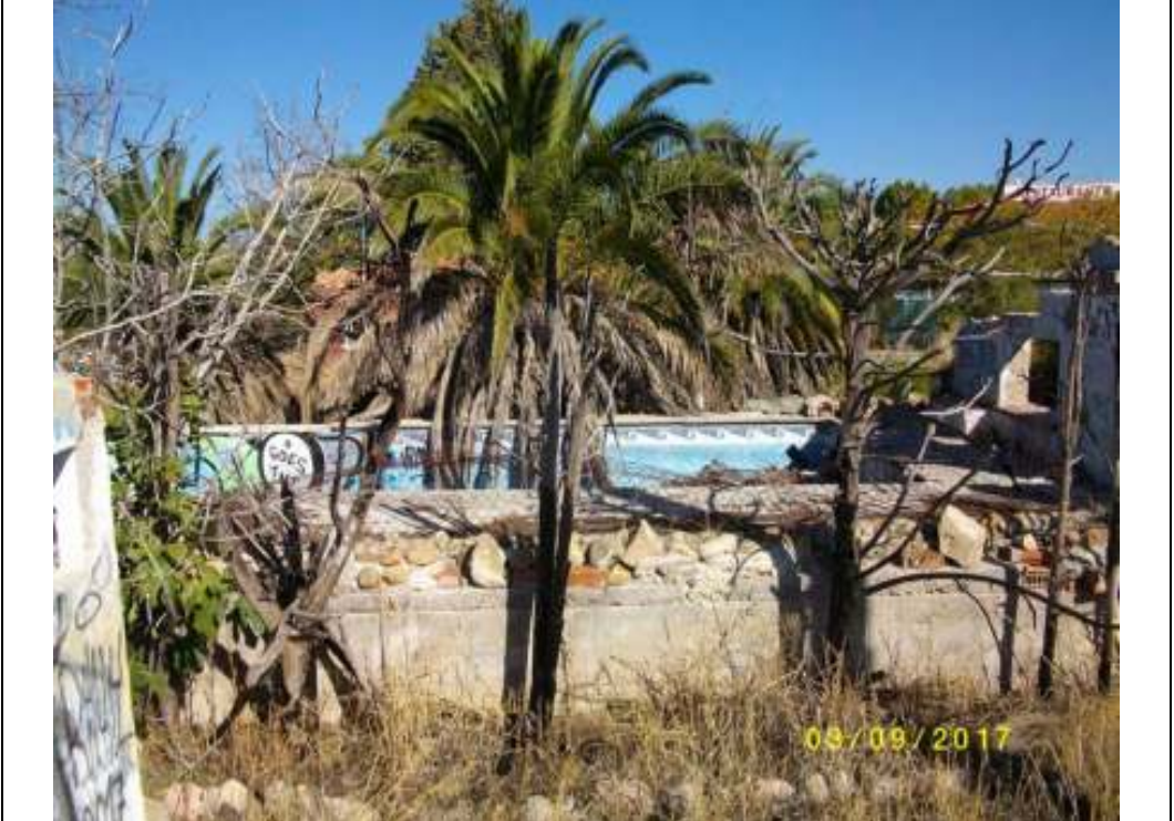
Fotografía nº 93 (Parcela B): vaso de piscina y edificaciones parcialmente demolidas
