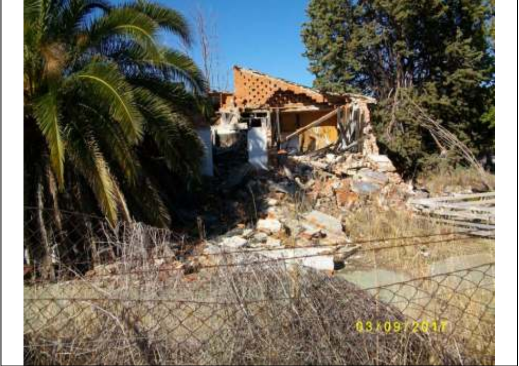
Fotografía nº 97 (Parcela B): edificación demolida (restos cerámicos, hormigón y metálicos)
