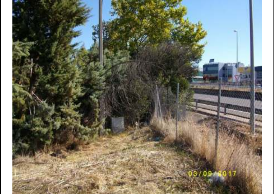
Fotografía nº 32 (Parcela C): valla de separación de parcela con la carretera M-506
