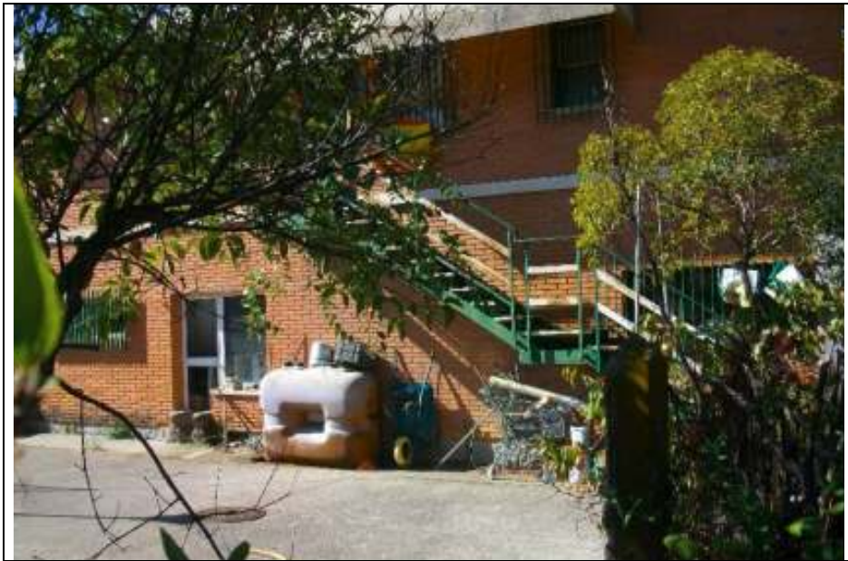
Avda. Príncipe de Asturias nº 3: fotografía del depósito de gasoil; deposito aéreo, sobre zona solada; estimamos que no entraña riesgo de contaminación del suelo.
