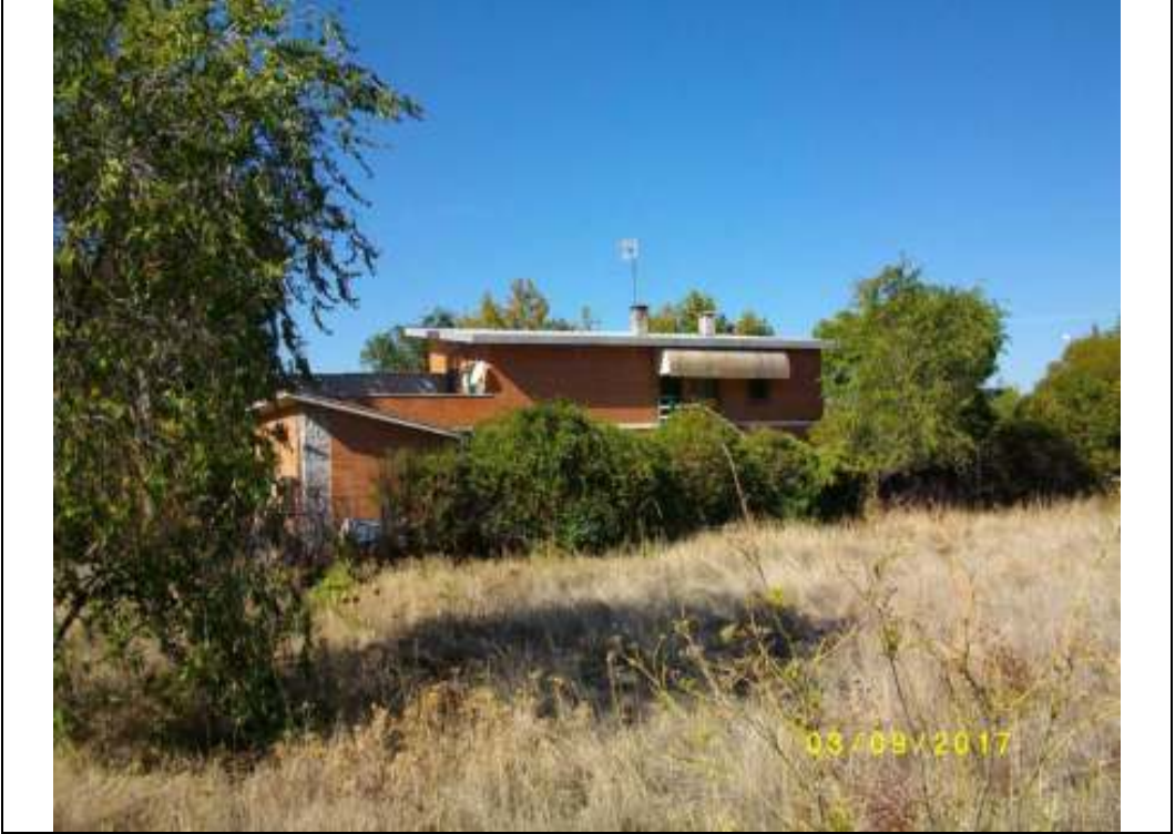
Fotografía nº 29 (Parcela D): vista lateral de edificación principal
