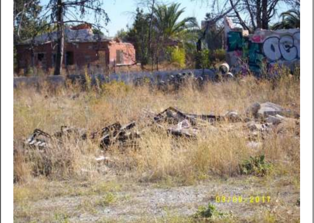
Fotografía nº 79 (Parcela A): escombros de diversos materiales (madera, cerámicos, hormigón)
