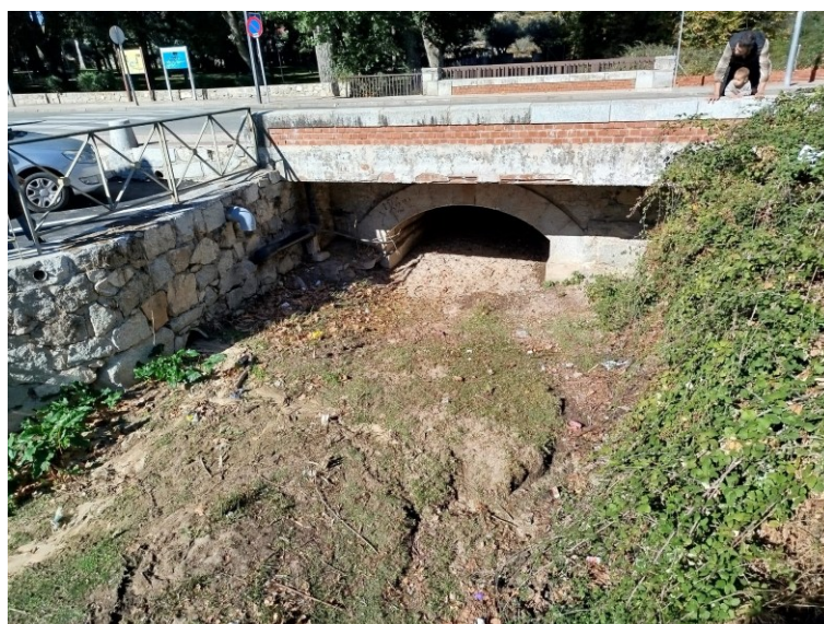
Figura 2. Puente calle La Nava
