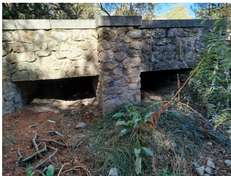
Figura 4. Puente urbanización Puentelasierra
