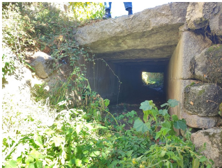
Figura 3. Puente carretera de Cerro Alarcón
