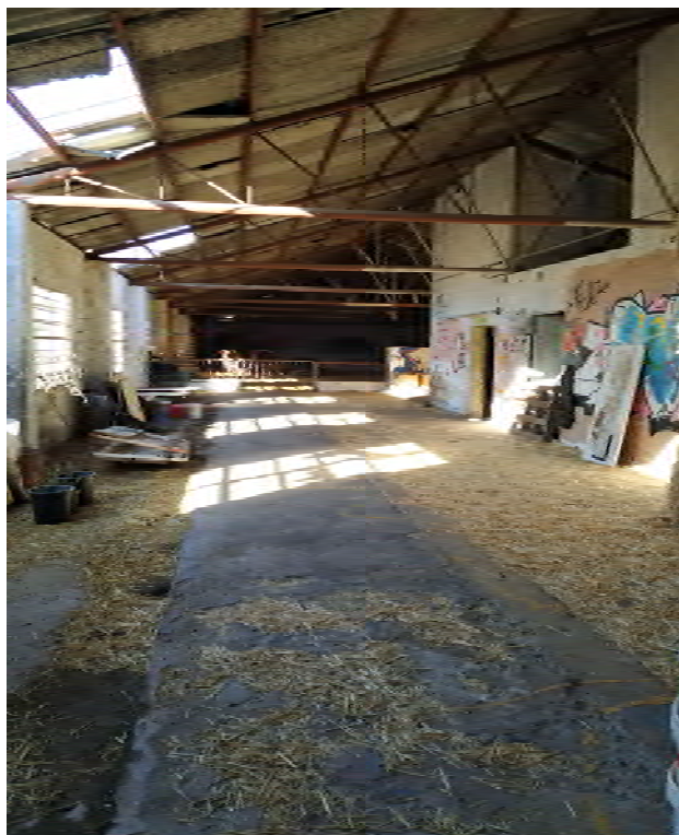
Foto 23. Vista General del Interior de la nave
