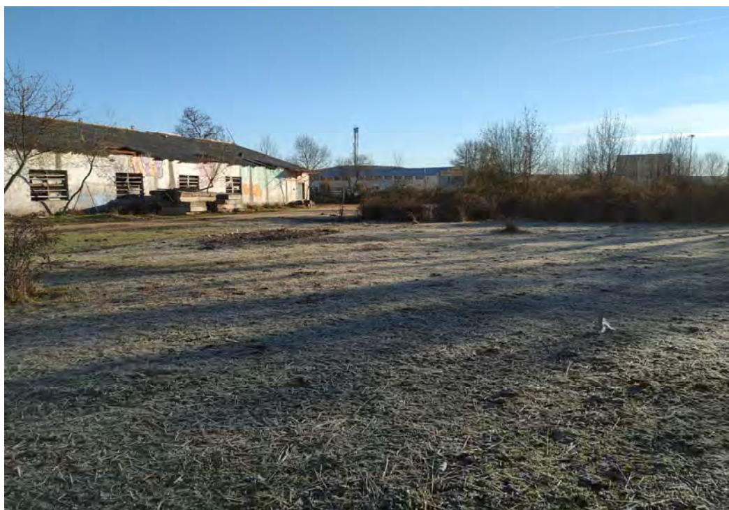
Foto 21. Vista de la parte Sur de la nave
