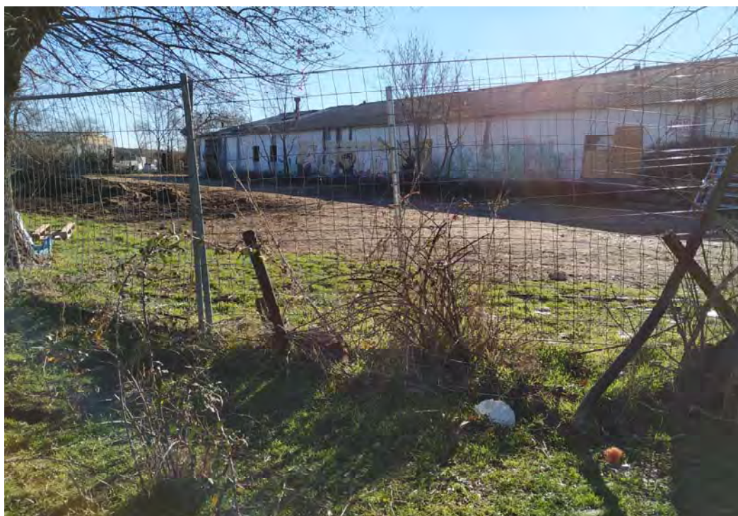
Foto 20. Vista de la parte Norte de la nave
