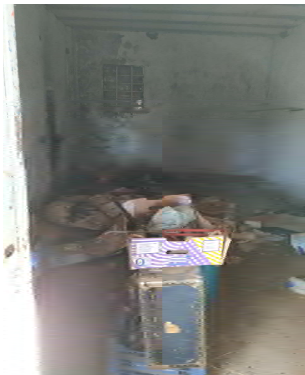
Foto 25. Habitación interior de la nave
