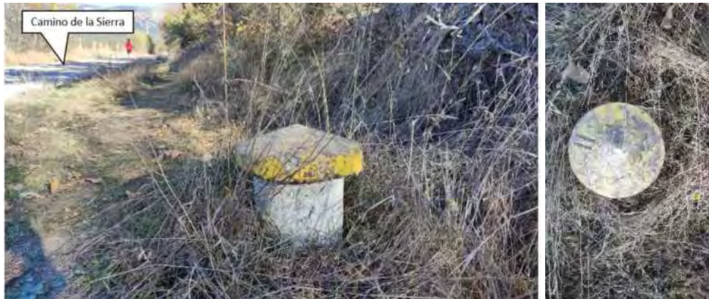
Figura 73. Hitos de señalización del trazado actual conducción de abastecimiento, junto al camino de la Sierra, 26 de octubre 2021. Fuente: elaboración propia.
