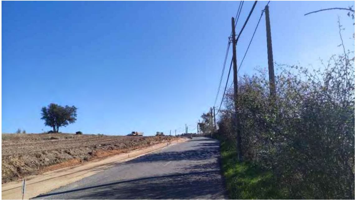
Figura 85. Obras de construcción del carril bici en el camino del Valle, 26 de octubre 2021. Fuente: elaboración propia.
