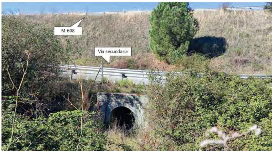
Figura 83. Cruce del trazado del Tramo 3 con la M-608, 26 de octubre 2021. Fuente: elaboración propia.
