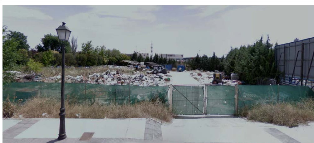
Fotografía nº 18: vista del estado de la parcela de la Avda. príncipe de Asturias nº 5
