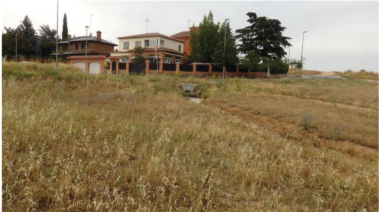
Fotografía 1 Aliviadero actual y cauce que ha erosionado el caudal del mismo
