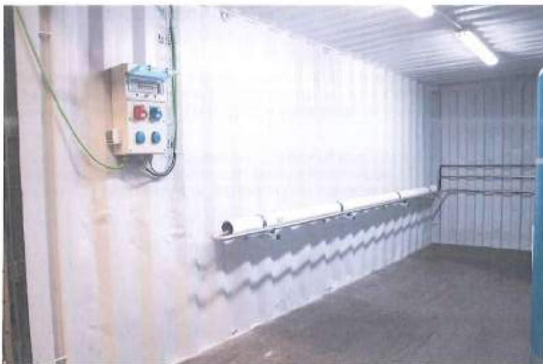
Vista de portamembranas para 4 elementos de membranas VONTRON.
