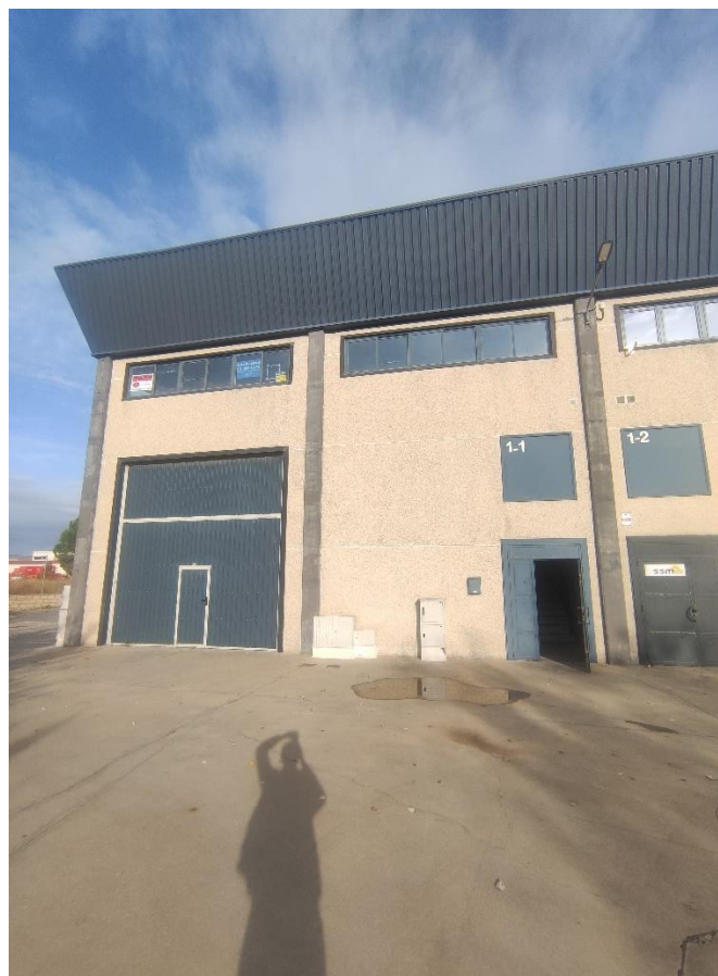
Ilustración 4. Entrada a la nave vista persona.
