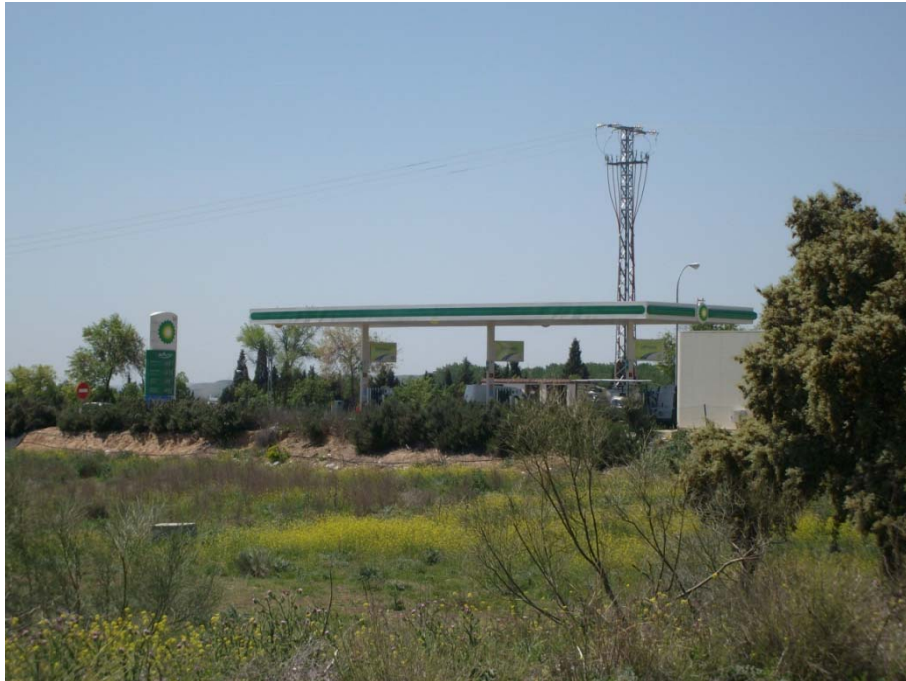
Gasolinera situada junto a la carretera de Madrid.
