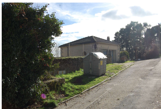
Contenedores de recogida de residuos situados en el ámbito objeto de la modificación.
