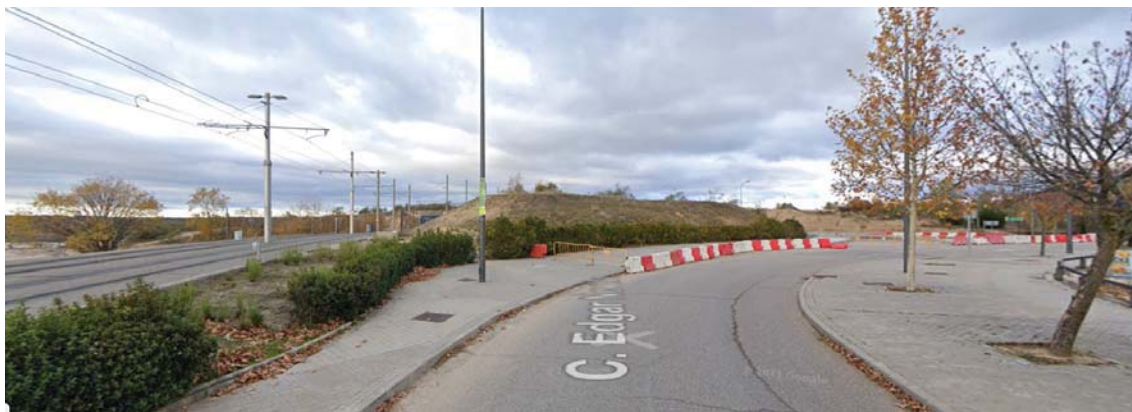
Imagen Nº 3.5.. Imagen de la red viaria ejecutada y la traza de la infraestructura del Tren Ligero
