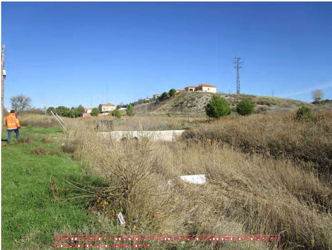
Figura 3.2.1.5.- Curso de agua denominado Cañada de Mingorrubio, por donde cruza en hincas la conducción, en las inmediaciones a la carretera M-318 que separa ambas urbanizaciones (Fuente: Canal de Isabel II)
