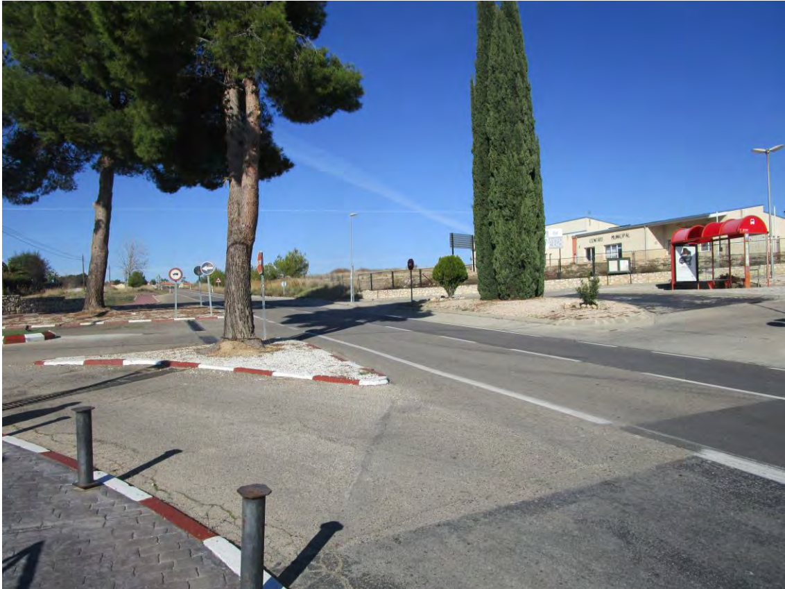
Figura 3.2.1.9. - Cruce en ninca por la carretera M-320 entre las urbanizaciones de Balcón del Tajo Este y Urtajo. (Fuente: Canal Isabel II)
