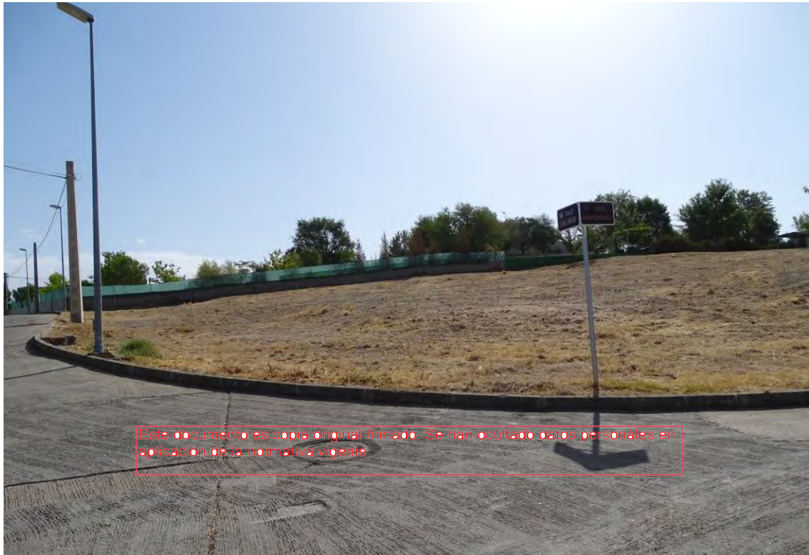
Figura 3.2.1.8.- Cruce de la calle de los Lirios con Avenida Jard3n de Miraltajo, en la urbanizaci3n Balc3n del Tajo Este, pon d3nde discurre la conducci3n de entrega a la urbanizaci3n. (Fuente: Elaboraci3n propia)
