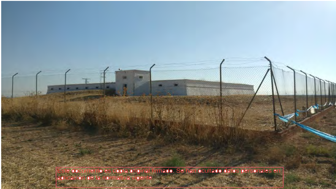
Figura 3.2.1.1.- Depósito municipal existente en Colmenar de Oreja (Fuente: Canal de Isabel II)
