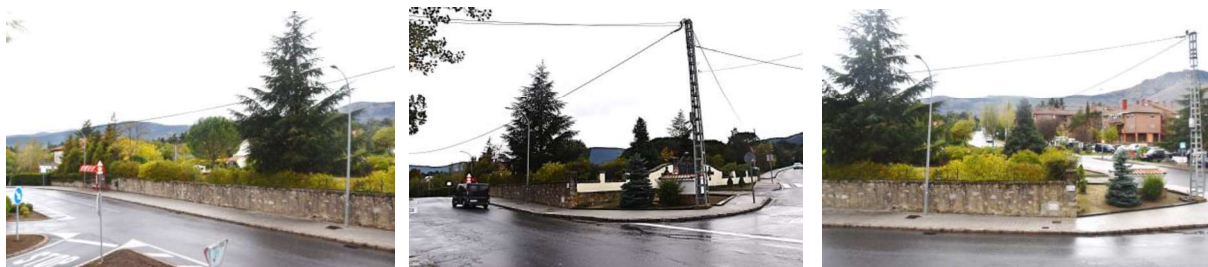
Imagen del estado actual calles Molino de la Cruz y Calvario. Fuente: Propia, 2022
