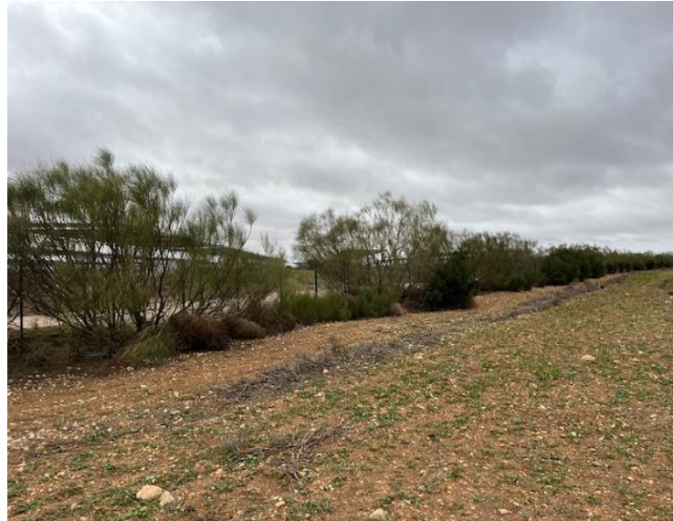
Imagen 84. Pantalla vegetal en instalacion fotovoltaica con especies de porte similar al planteado en PF La Mina.
