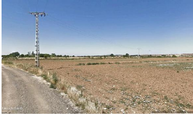
Imagen 11. Vial con apoyo cercano al punto de conexión.
