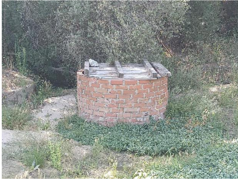
Fotografía 15. Edificaciones presentes en el entorno de actuación. Pozo (nº6).
