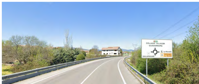
Ilustración 7. Foto estado actual M510
