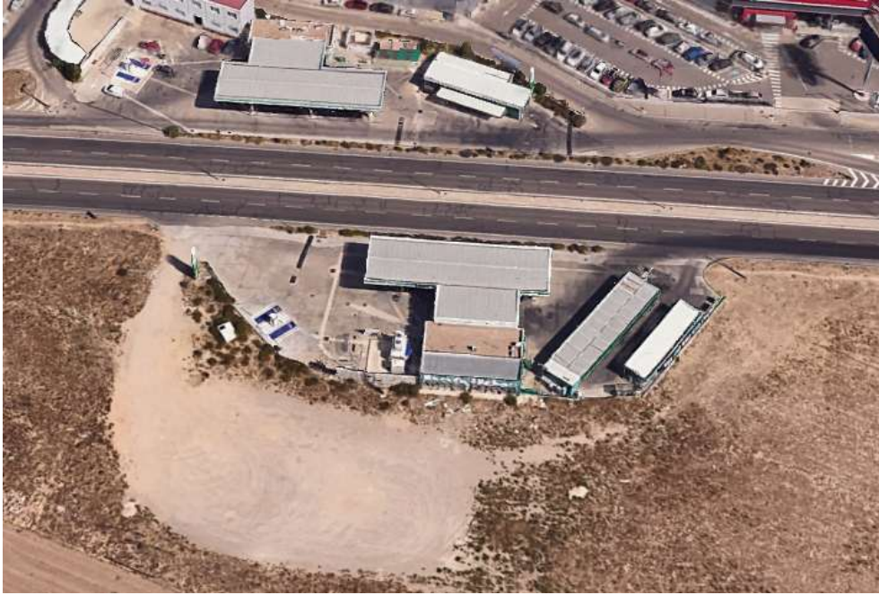
Estación de servicio. Fte. Google Earth
