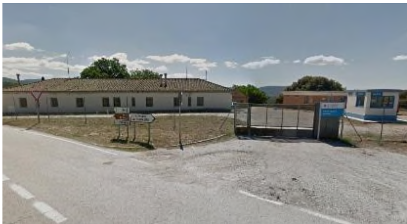
Vistas de la Central Eléctrica de El Villar desde el observador 3 (Fuente: Street View)
