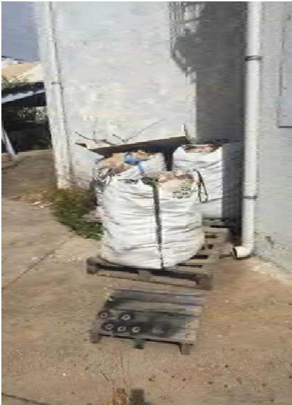
Acopios de residuos de construccion en sacos
