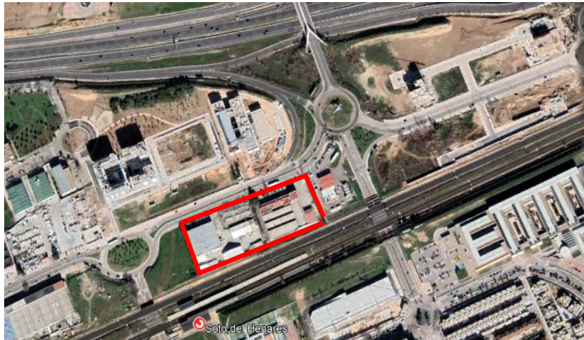
Foto aérea del entorno del ámbito
