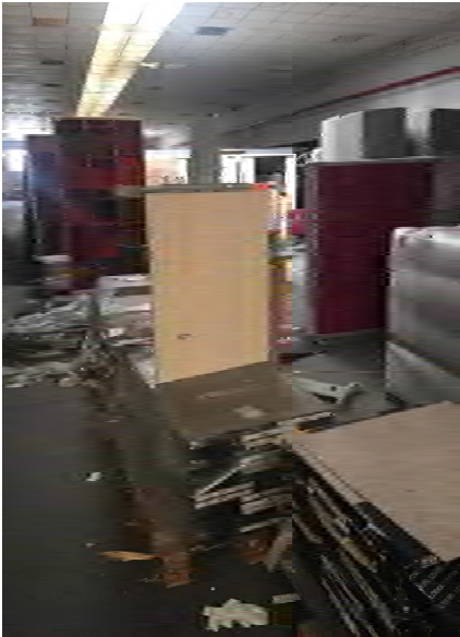
Estado actual en el interior del edificio. Almacenamiento de muebles
