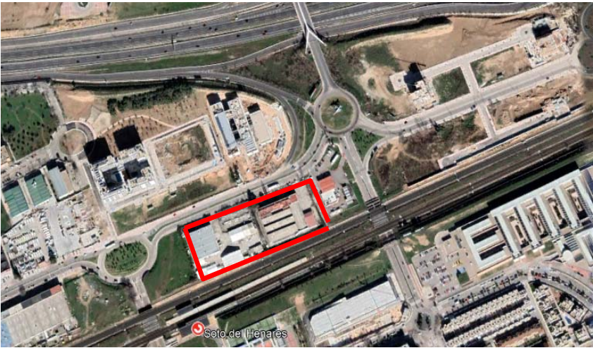
Foto aérea del entorno del ámbito
