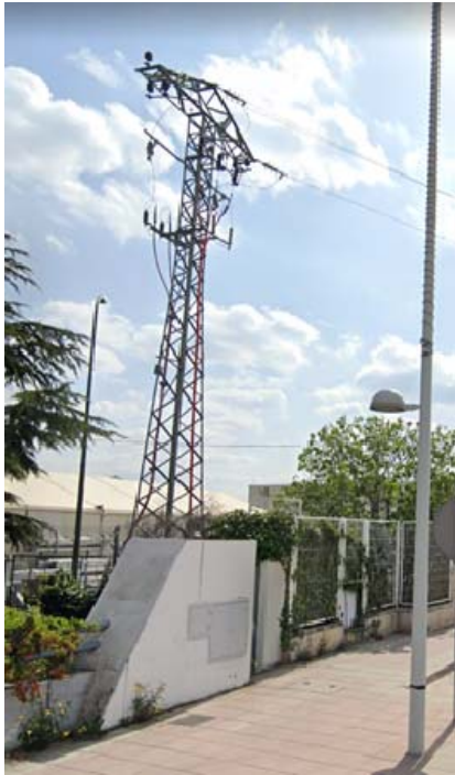
Vista torre de celosía metálica de energía eléctrica a desmontar
