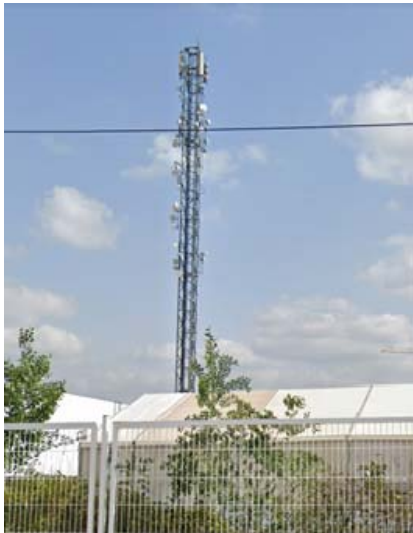
Vista torre de comunicaciones a desmontar
