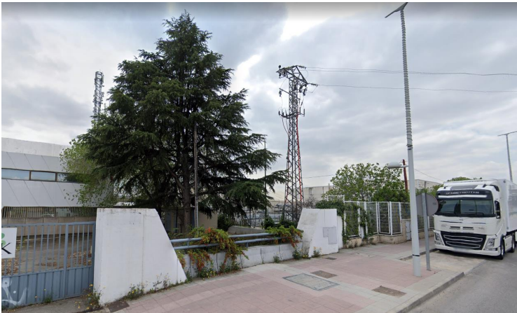
Torre eléctrica en el interior del ámbito
