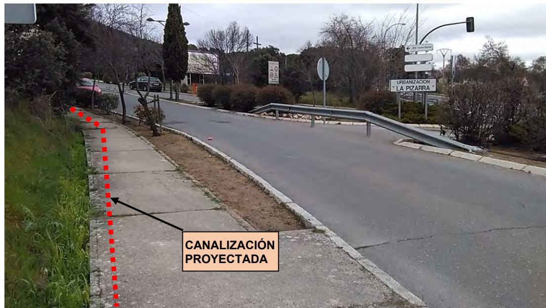
RECORRIDO L4, por calle Amboto, en Urbanización La Pizarra
