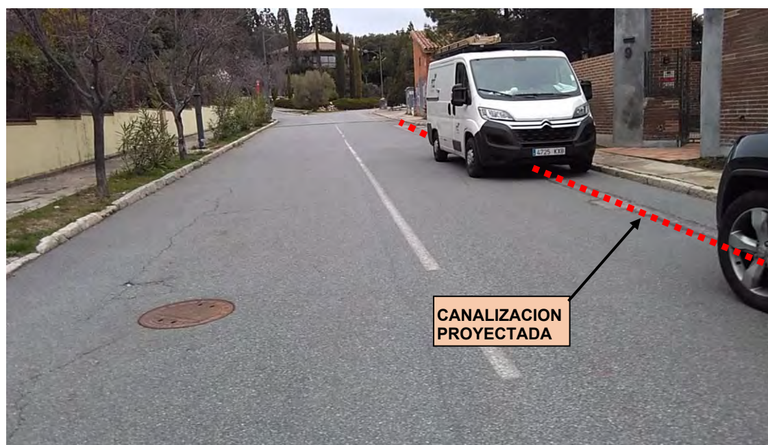
RECORRIDO L4, por calle Udala, en Urbanización La Pizarra
