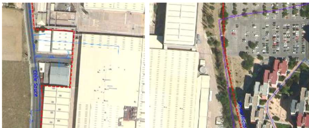
Figura 19. A la izquierda, vista de la acometida situada en la C/Sauce. A la derecha, vista de la arteria DN 1200 que discurre por el aparcamiento público del Paseo Riazor
