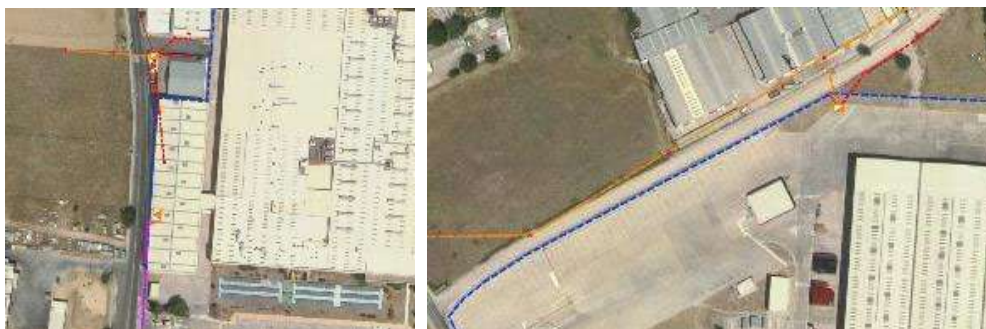
Figura 25. Imagen izqda: Vista de la línea en AT que conecta al ST Casbega y vista de la línea aérea BT que entra en el sector. Imagen dcha: CT ubicado al Norte del APD-16
