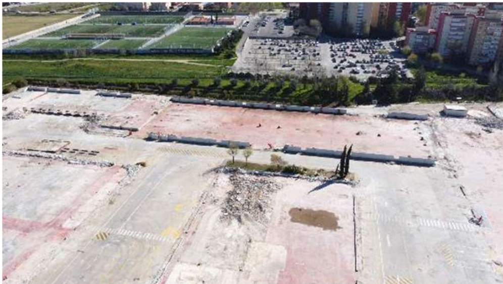
Figura 10. Fotografía oblicua del ámbito Este-Oeste, de fecha 15 de marzo de 2021. (Fuente: elaboración propia)
