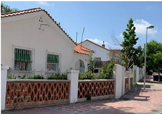
Cerramiento permeable con fábrica de ladrillo
