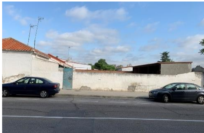
Edificaciones auxiliares en parcela
