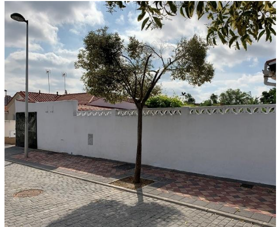
Cerramiento macizo con celosía en coronación
