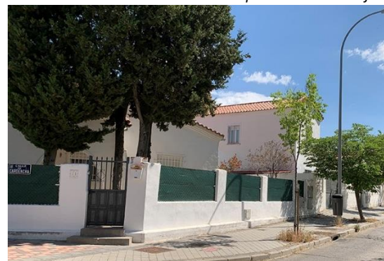
Cerramiento semipermeable cubrición textil
