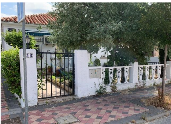
Cerramiento permeable con fábrica de ladrillo
