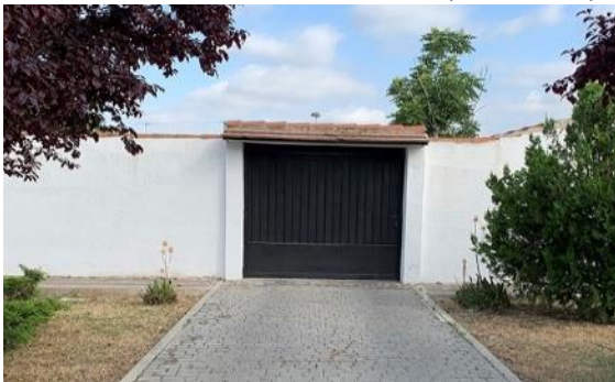
Cerramiento macizo y portón
