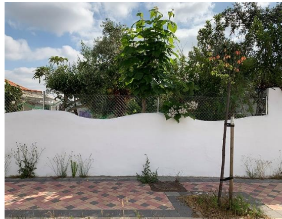
Cerramiento macizo pero permeable en coronación
