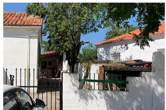
Edificaciones auxiliares en parcela
