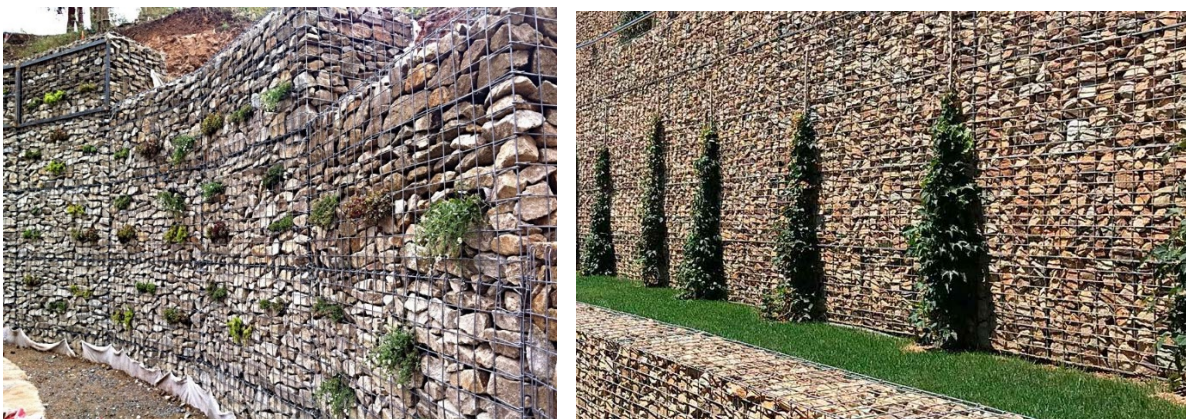
Ejemplos de muros de gaviones naturalizados
