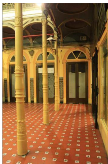
Planta baja. Vista general de la escalera y el pasillo (las dos fotografías superiores) y vista general del patio con detalle de los soportes de fundición, solado y bóveda (a la izquierda).
