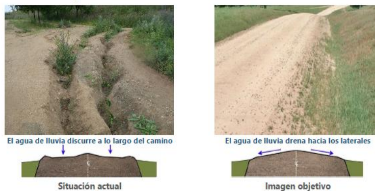
Figura 16. Esquema de situación actual y objetivo para el drenaje de caminos a través de cunetas. Fuente: Plan Especial Cerro de Almodóvar.
