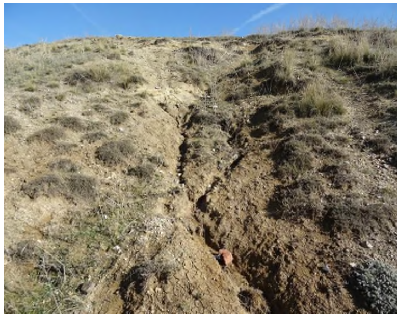
Vista de la mitad superior de la cárcava de C11 que tiene un grado de erosión medio en cuanto a anchura e incisión.
