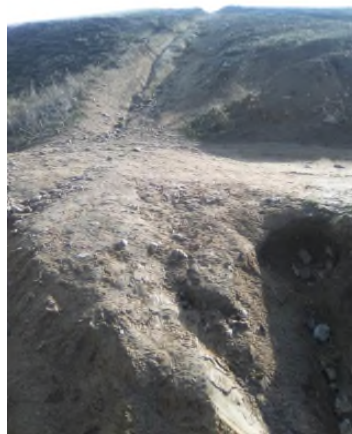
Vista en primer plano de la cabeza de la cárcava C1, y al fondo la cárcava C2 que sube hasta la plataforma y que tiene un grado de erosión e incisión alto (ancha y profunda).
