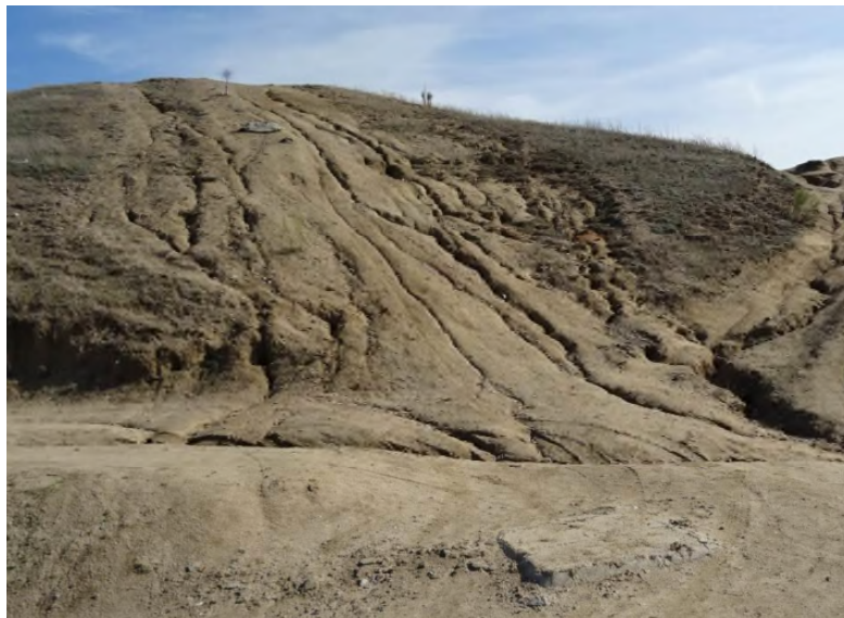
Vista de la parte superior de la zona de la C7, donde el grado de erosión es máximo en erosión laminar y en generación de regueros que llegan a pasar a cárcavas.
