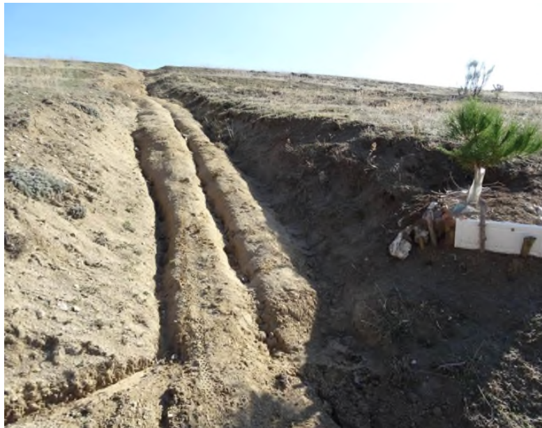
Vista del tramo superior de la cárcava de C10 que presenta un alto grado de erosión tanto en anchura como en incisión.
