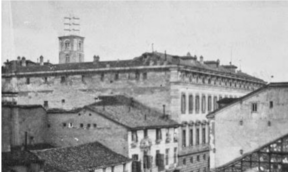
Torre óptica de la Aduana
