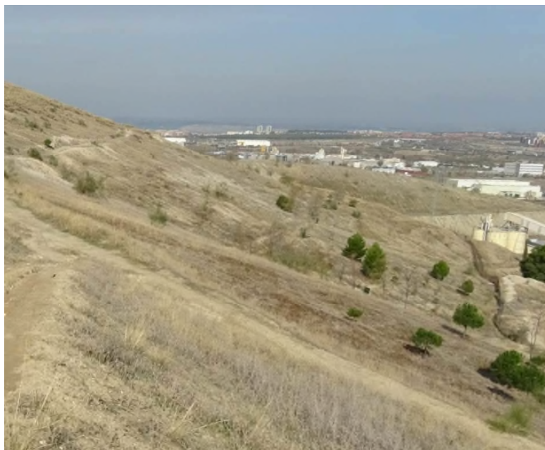
Vista general de la ladera oriental del cerro, donde se localiza el talud T4. Parece tratarse de un antiguo talud generado por la actividad minera y que se encuentra parcialmente revegetado. Presenta numerosos regueros y cárcavas y habría que estudiar detalladamente el riesgo de inestabilidad de este talud.
