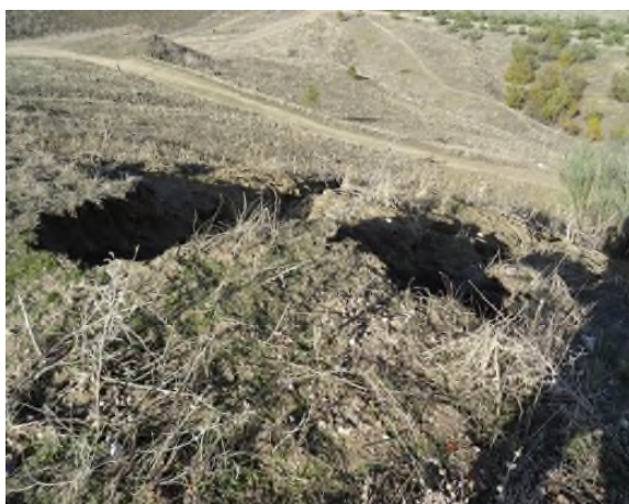
Los escarpes aparecen en sombra por el hueco generado por el deslizamiento en D1.
