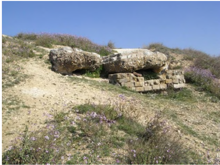
Fig. 4 Estado actual del observatorio blindado construido en la Guerra Civil Española
