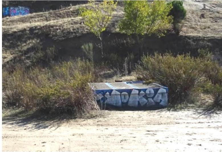
Vista del Talud T1, el cual no parece presentar problemas de inestabilidad.
