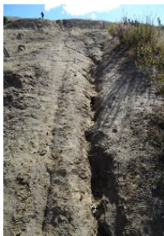
Vista de la lineación erosiva C1 (radial) desde abajo. Se observa un grado de erosión e incisión alto.
