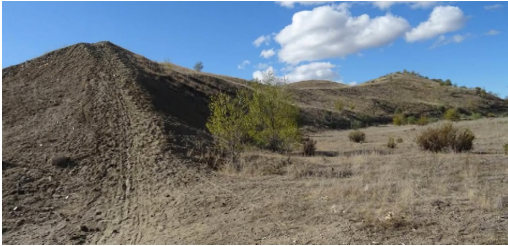
Vista de la zona norte del talud T5. Se han identificado numerosos procesos erosivos como consecuencia de las excavaciones realizadas para la explotación minera y a los trabajos de urbanización del sector.
