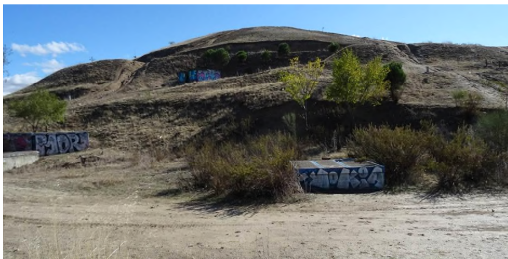
Vista general del talud T1 en la parte interior y del talud T2 en la zona intermedia de la vertiente occidental del cerro.
