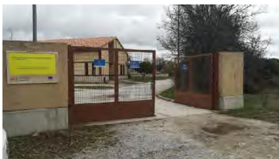
Figura 2.1.2.1.- Acceso EDAR (Fuente: Elaboración propia)
