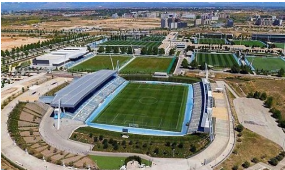
Instalaciones deportivas en la parcela DO 190
