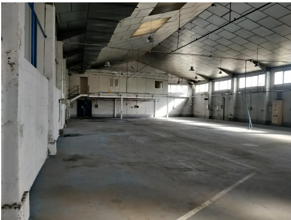
Vista interior de la crujía suroeste con la paredes de separación de ambas crujías
