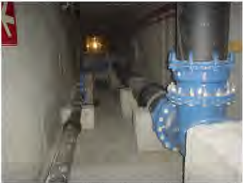
APOYOS Y ANCLAJES EN GALERÍA
