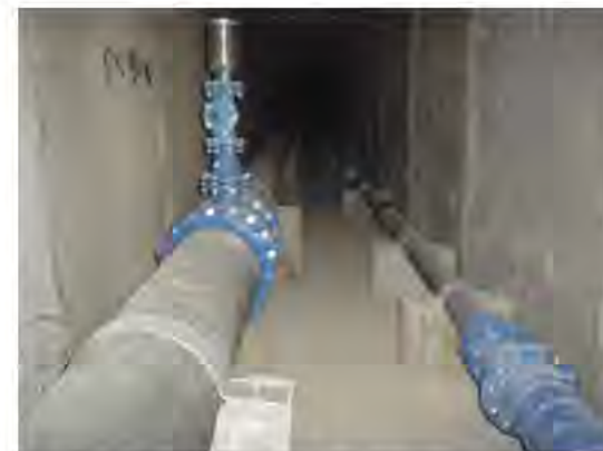
INSTALACIÓN EN GALERÍA
