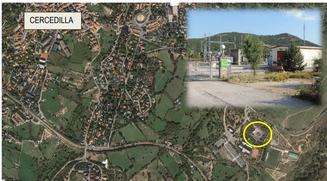
Figura 2. Subestación eléctrica en Cercedilla. Fuente: Elaboración propia.
