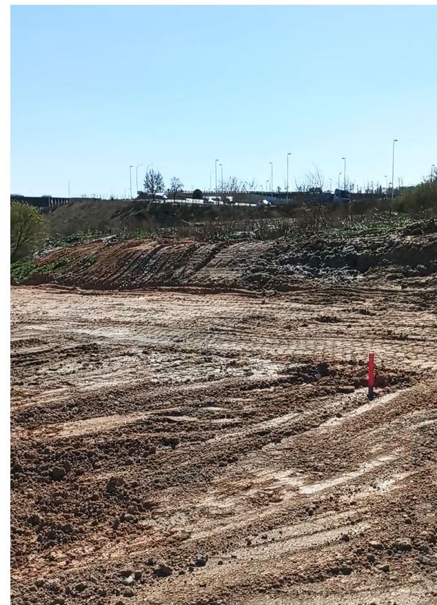
Figura 50. Zona 2 (fotografía de marzo de 2026 tras la retirada de materiales plásticos y restos de césped híbrido por gestor autorizado - Apéndice VII). Fuente: elaboración propia.
