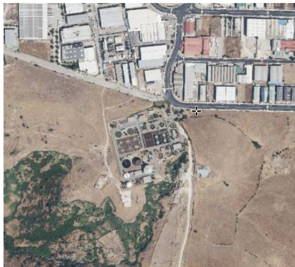
Fig 17. Imagen aérea de EDAR Navarrosillos
