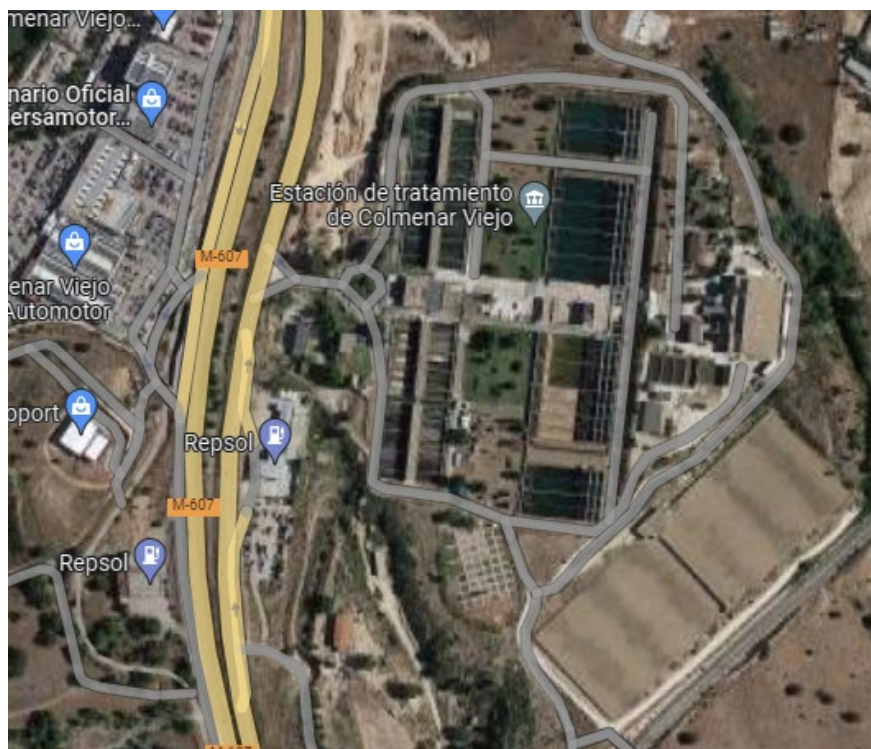
Fig 14. Imagen aérea de la ETAP Colmenar
