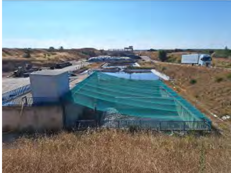
Balsas de lixiviados y pluviales actuales
