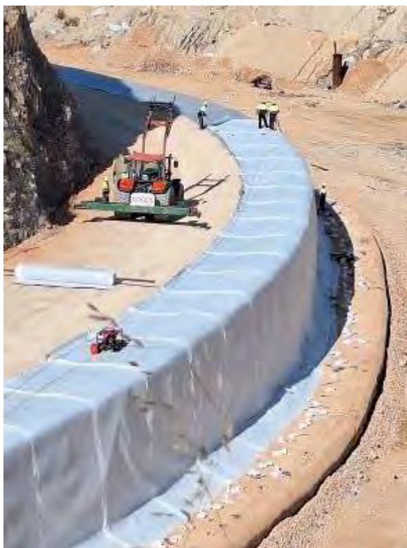
Trabajos de ejecución de gaviones en Celda nº2
