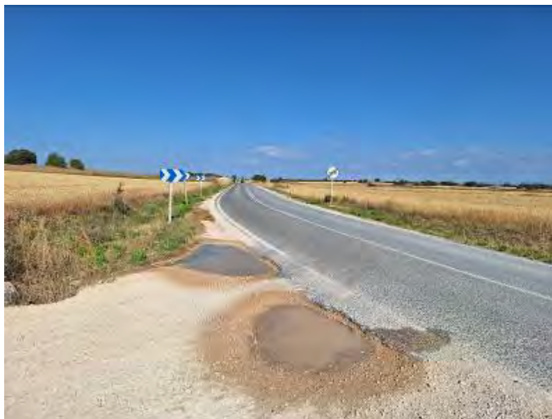
Cruce de la M-221 y el Cordel de Pozuelo del Rey
