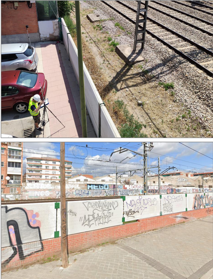
Figura 4. Muros existentes entre el aparcamiento “Barrio San José” y las vías de ferrocarril (arriba, fotografía tomada en campo desde las escaleras de acceso al paso elevado de la Avenida del Sol) y entre la calle Hemisferio y las vías (abajo, fotografía extraída de Google Maps desde la calle Hemisferio).
