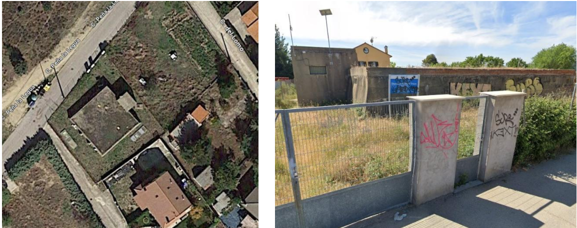
Figura 16. Depósito de regulación de Mangirón. Fuente: Google maps.
