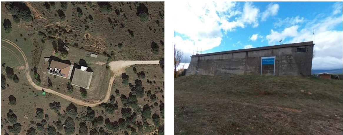
Figura 17. Depósito de regulación de Paredes de Buitrago y Serrada. Fuente: Google maps.
