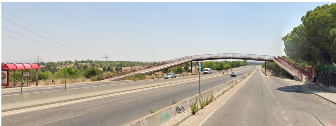
Imagen. Vista de la pasarela peatonal de cruce
