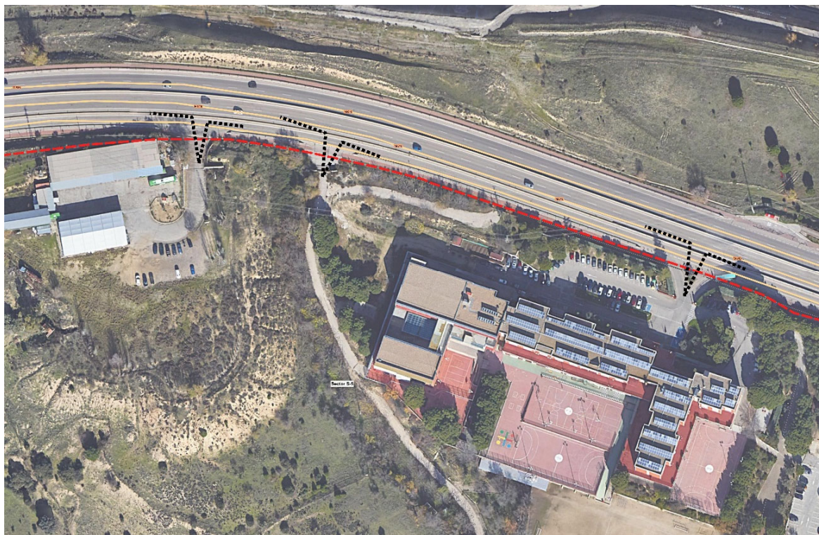
Imagen. Localización de los accesos a propiedades privadas existentes desde la antigua M-616.
