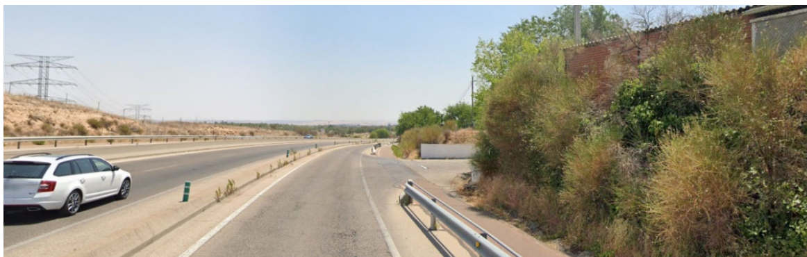
Imagen. Acceso actual a las instalaciones de cocheras de autobuses desde la antigua carretera M-616
