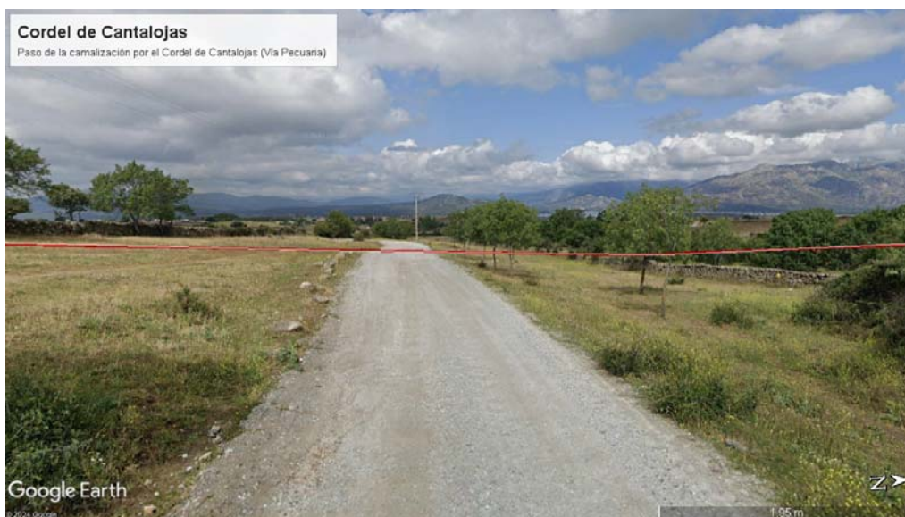
Figura 5. Paso de la canalización por el Cordel de Cantalojas.
