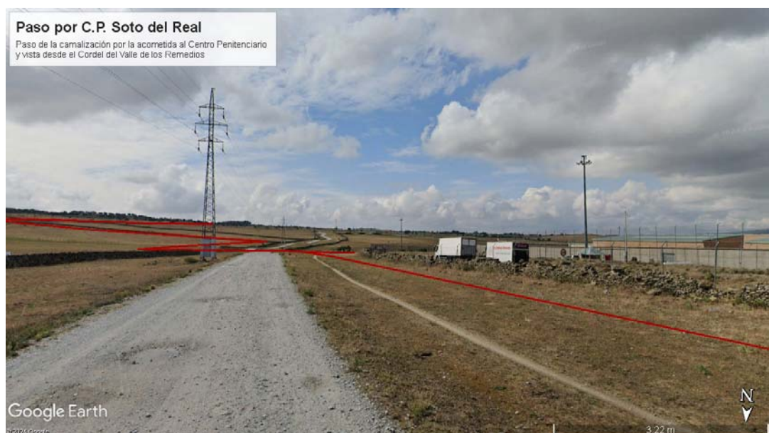
Figura 7. Paso de la canalización junto al C.P. de Soto del Real
