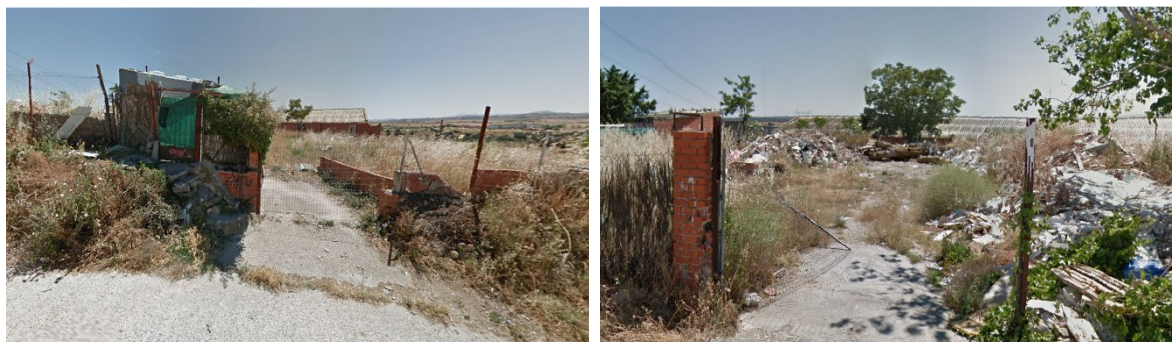
Figura 32. Zona de acopio de material y vertido en el ámbito de actuación.
