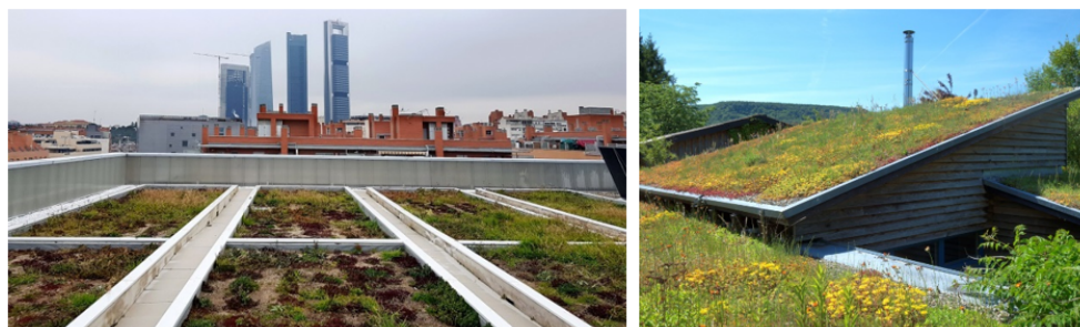
Figura 1.3: Imagen de cubierta verde extensiva plana (izquierda) e inclinada (derecha)
