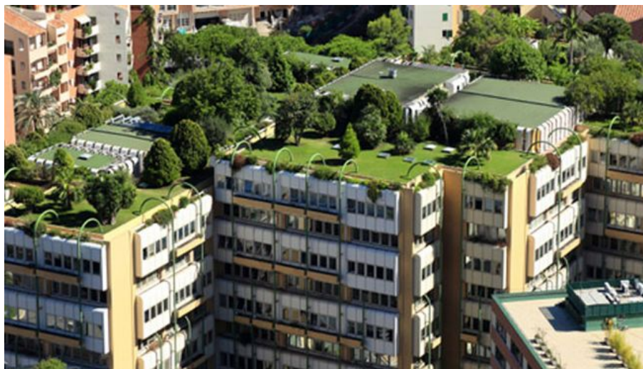
Figura 1.4: Imagen de cubierta verde intensiva
