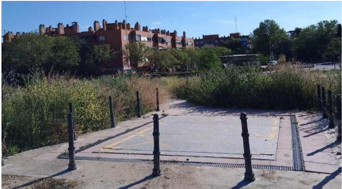
Figura 100. Vistas del ámbito (instalaciones del Metro de Madrid). Elaboración propia
