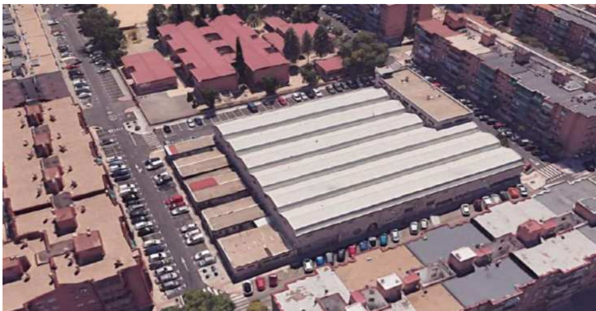
Figura 88. Aparcamientos en el entorno del CEIP Ciudades Unidas, depósito de vehículos Policía Local y asociación vecinal
