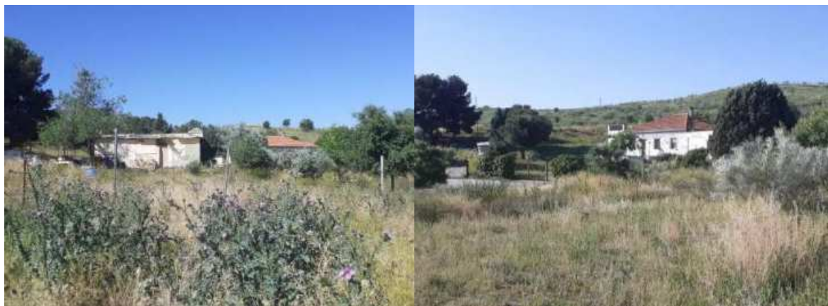
Figura 14. Edificaciones existentes. Elaboración propia
