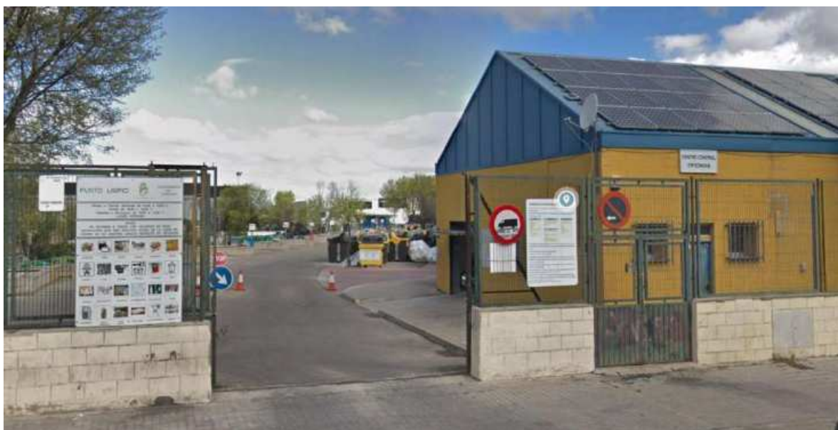
Figura 80. Punto limpio de Coslada-San Fernando de Henares
