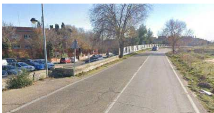
Figura 117. Carretera a Mejorada (tramo sur)
