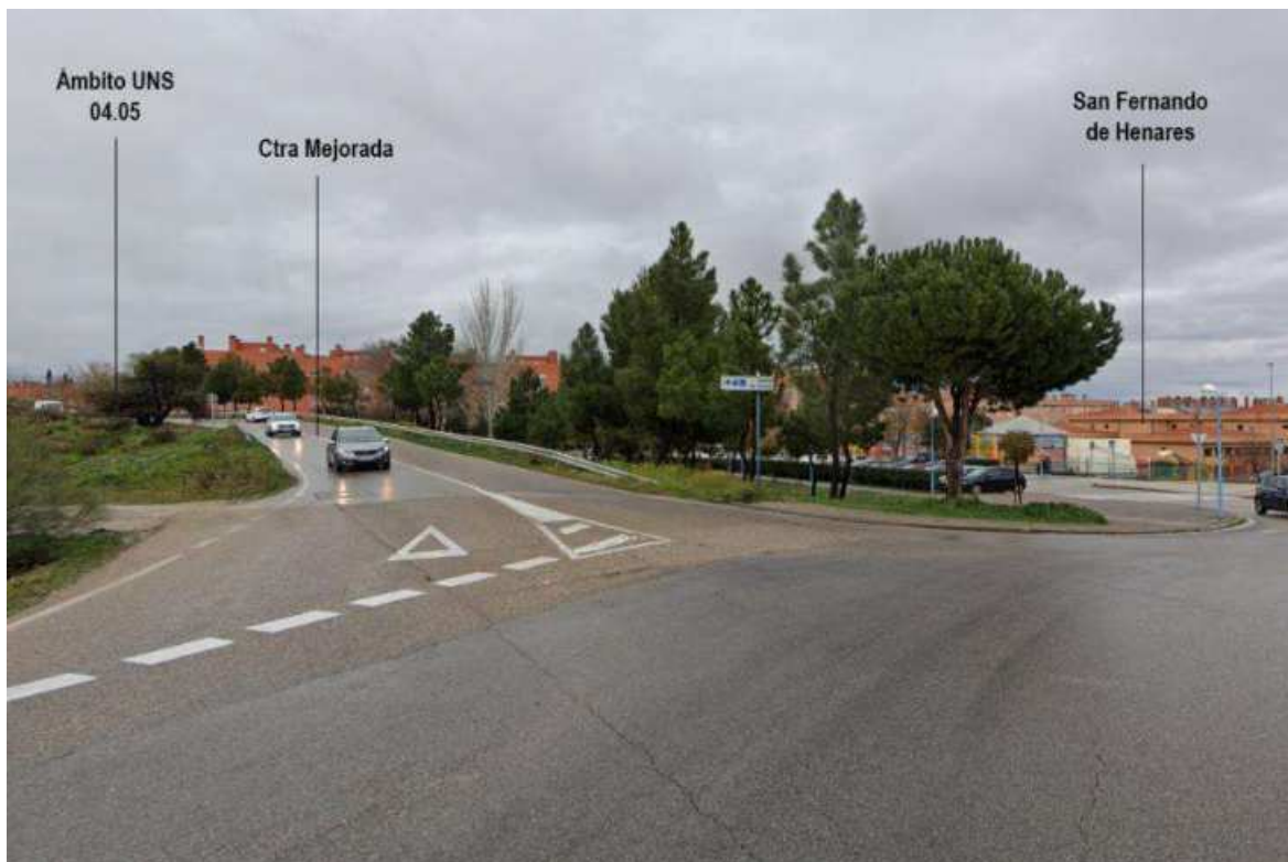
Figura 125. Tramo sur de la calle “Carretera de Mejorada”
