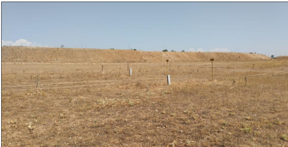
Fotografía 6. Señalización gaseoducto SUP-I-5.
