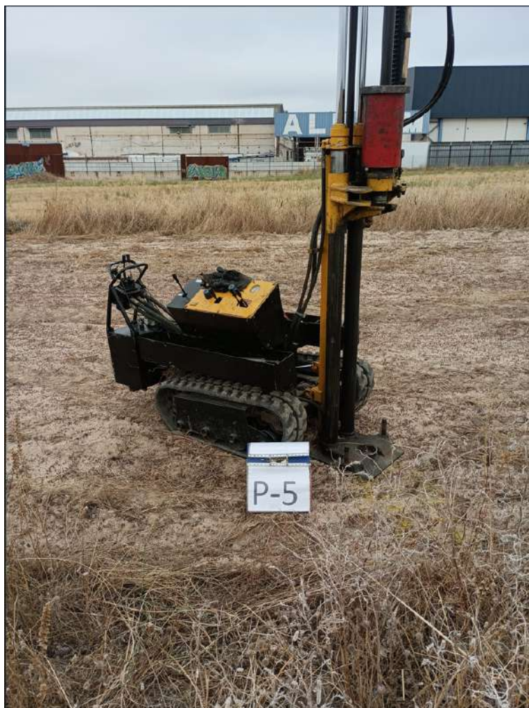
Ensayo de penetración dinámica, P5
