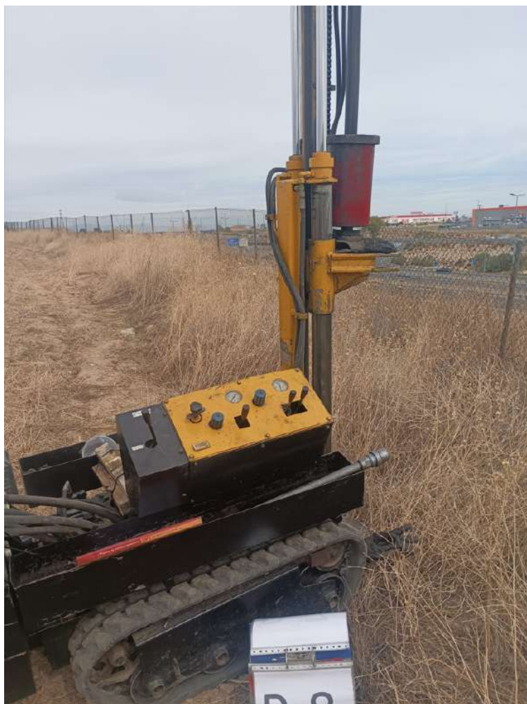
Ensayo de penetración dinámica, P8
