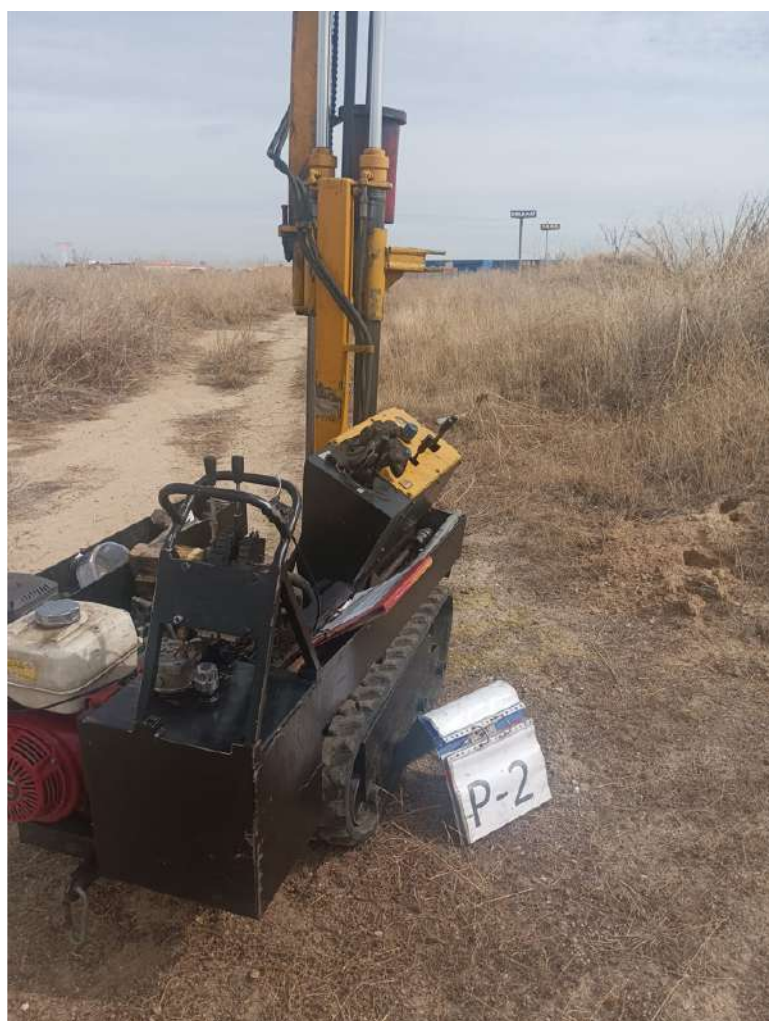
Ensayo de penetración dinámica, P2
