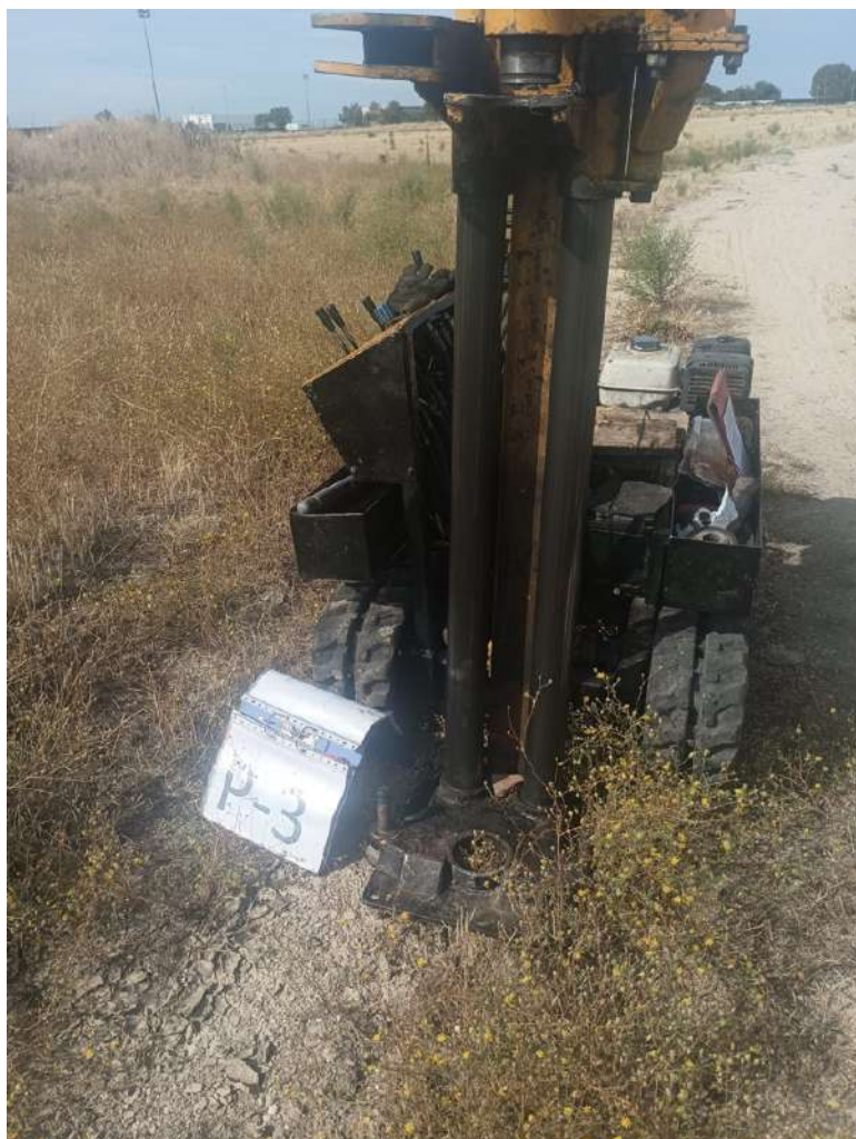
Ensayo de penetración dinámica, P3
