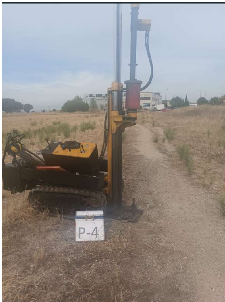
Ensayo de penetración dinámica, P4
