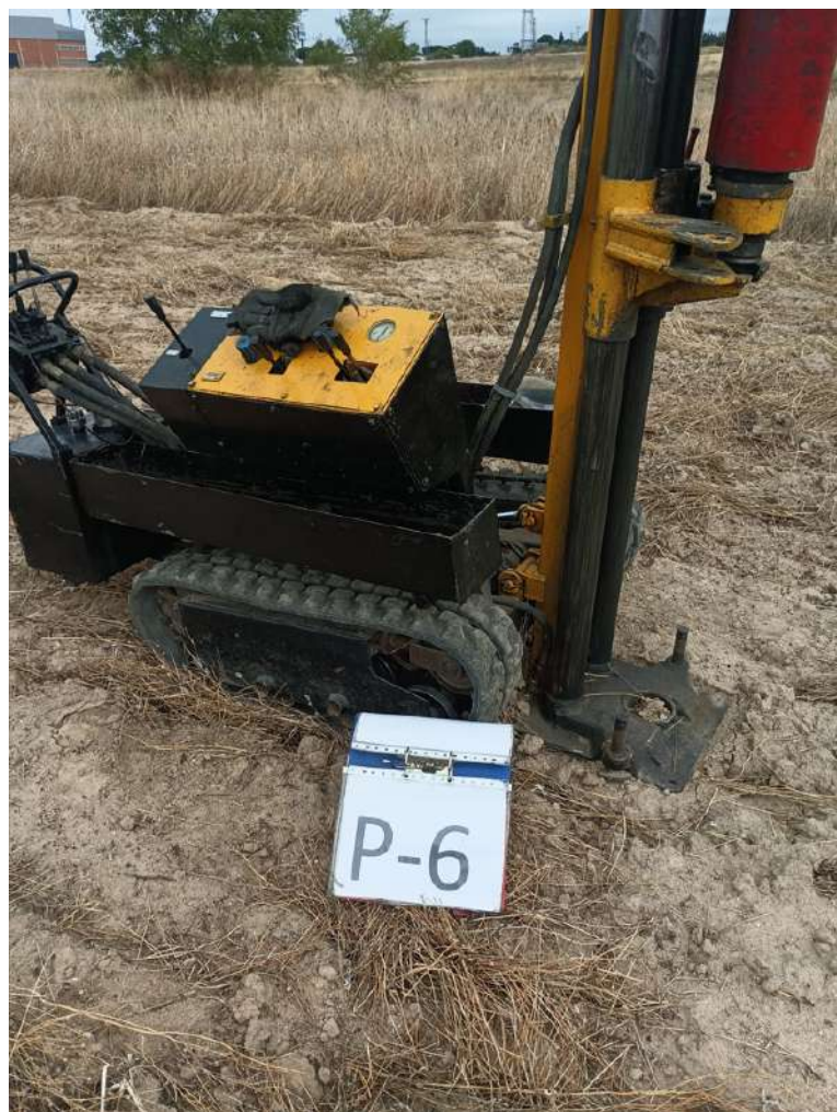
Ensayo de penetración dinámica, P6
