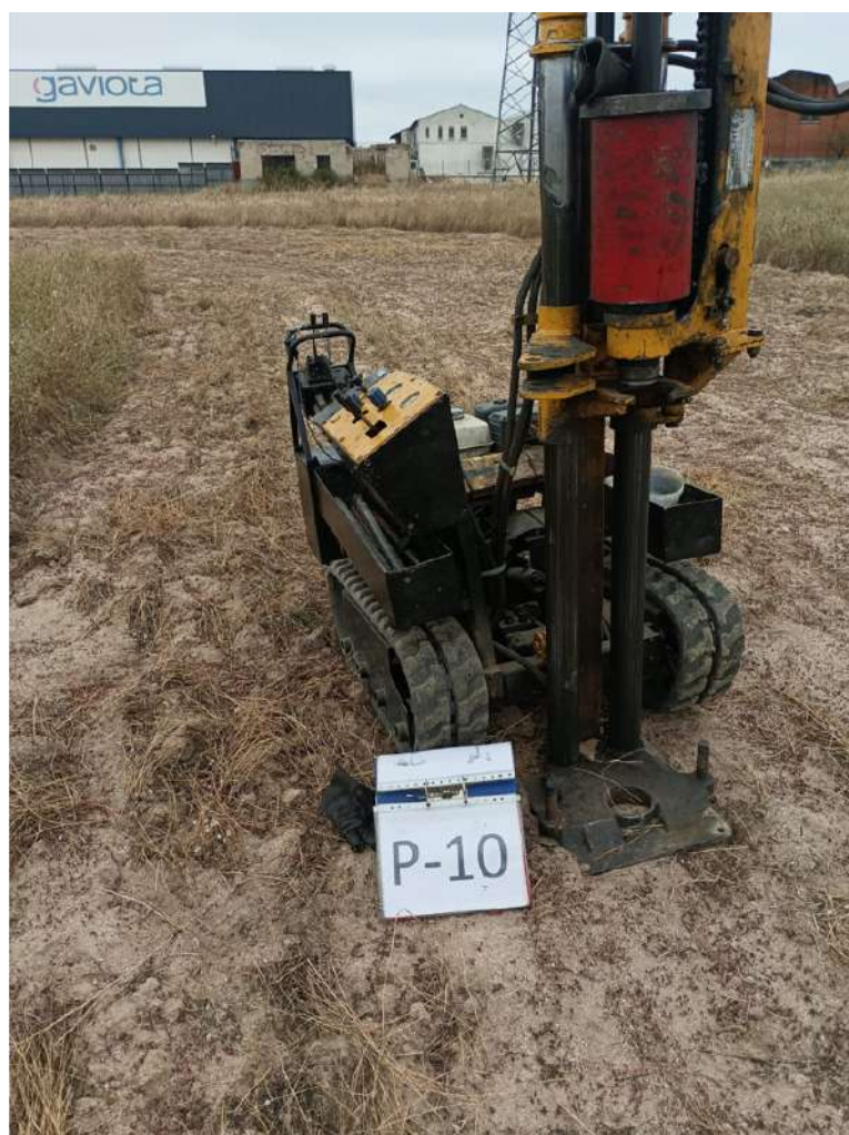
Ensayo de penetración dinámica, P10
