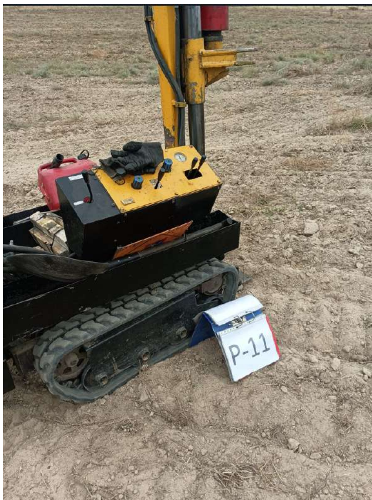
Ensayo de penetración dinámica, P11
