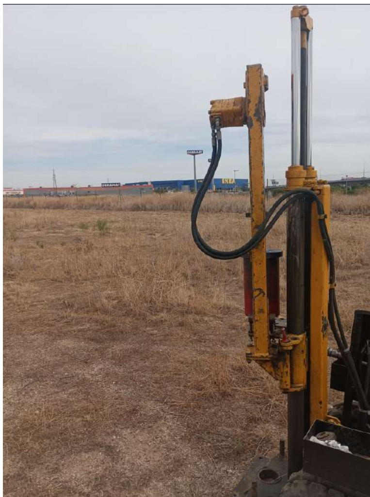
Ensayo de penetración dinámica, P7
