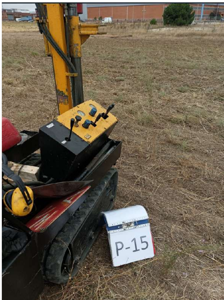
Ensayo de penetración dinámica, P15
