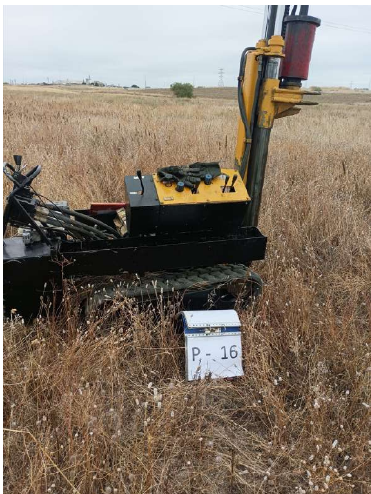
Ensayo de penetración dinámica, P16
