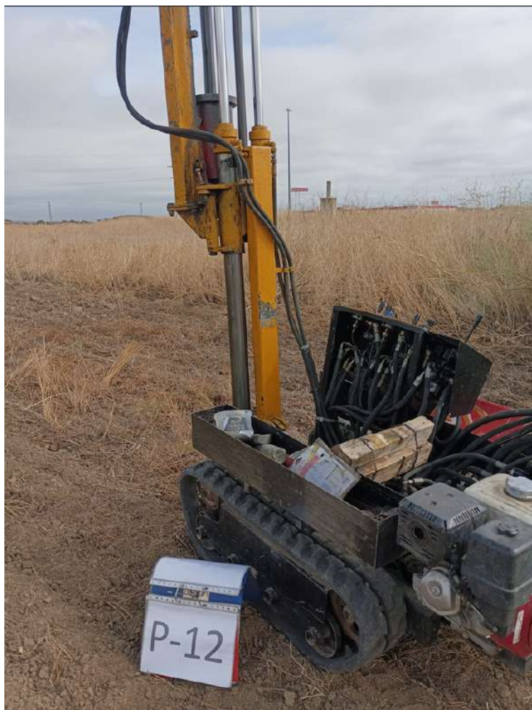
Ensayo de penetración dinámica, P12
