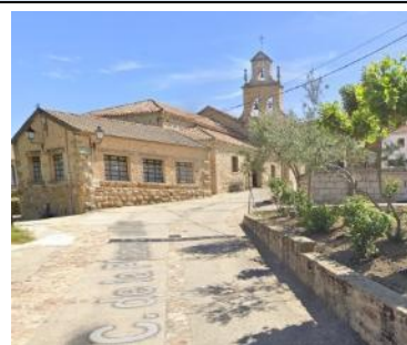
C/ la Plazuela del Cura (Paredes de B.)
