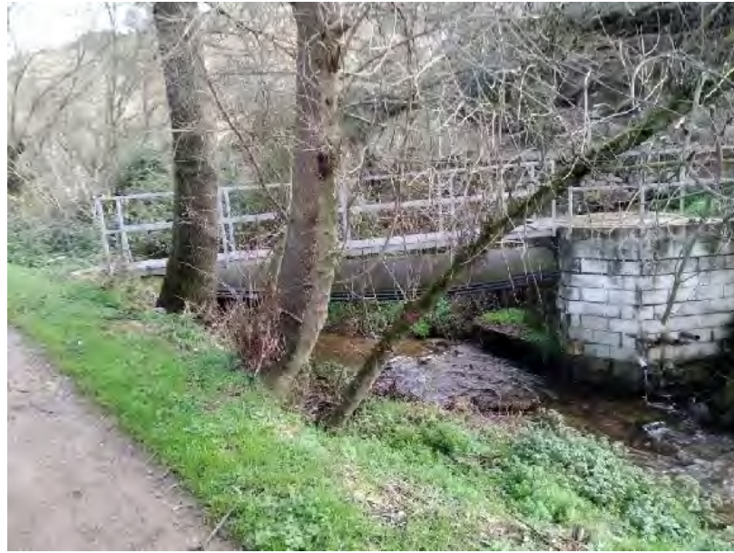
Figura 3. Tramo de la tubería actual sobre el arroyo de San Vicente, 17 de diciembre de 2020. Fuente: elaboración propia.
