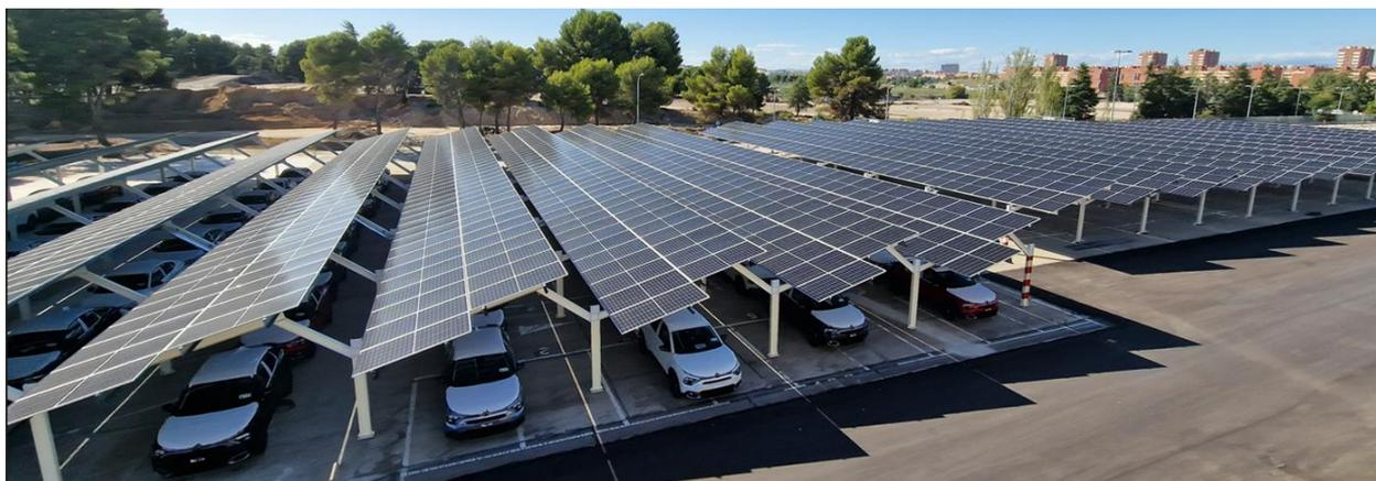
**Figura 6.** Vista aérea placas solares fotovoltaicas en marquesina (fase II): 1,1 MWp
