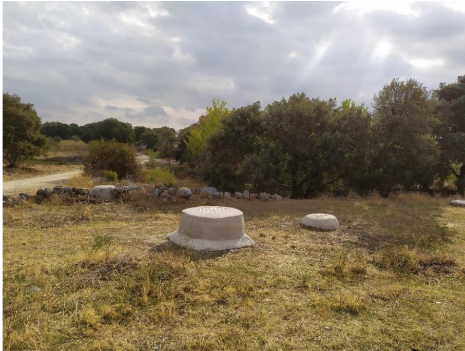
Figura 3. Localización del actual aliviadero CHAAL001. Fuente: visita a campo 20/09/2019.
